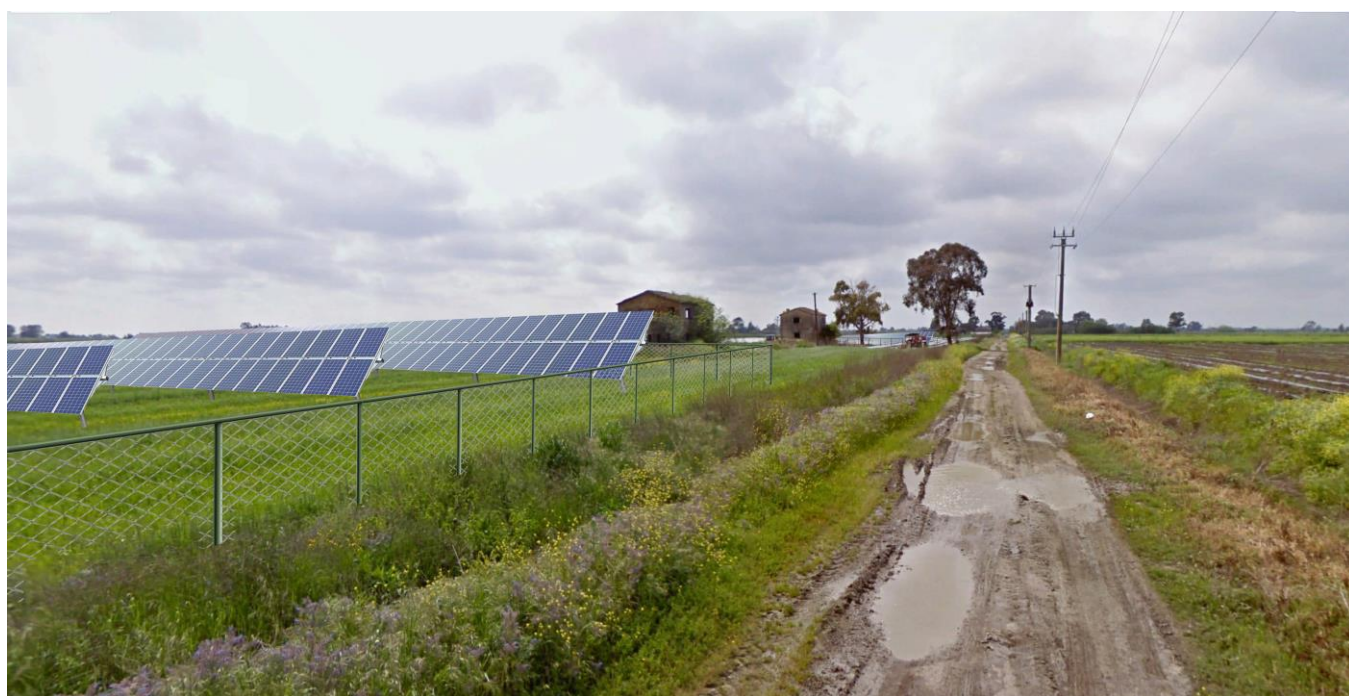
Tracker FOTO A – stato POST operam
