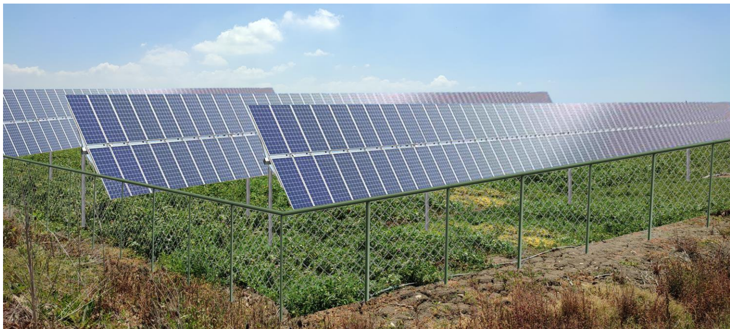
Tracker FOTO B – stato POST operam
