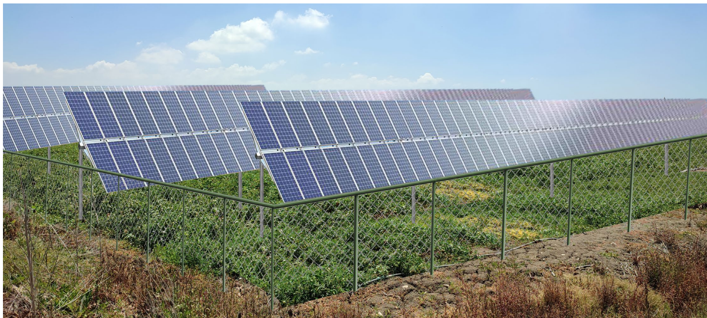
Tracker FOTO B – stato POST operam
