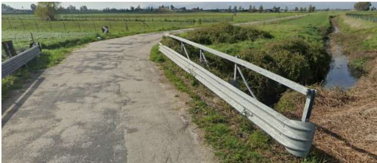
Figura 14: Interferenza Superficiale n.4 – Canali irrigui a cielo aperto
