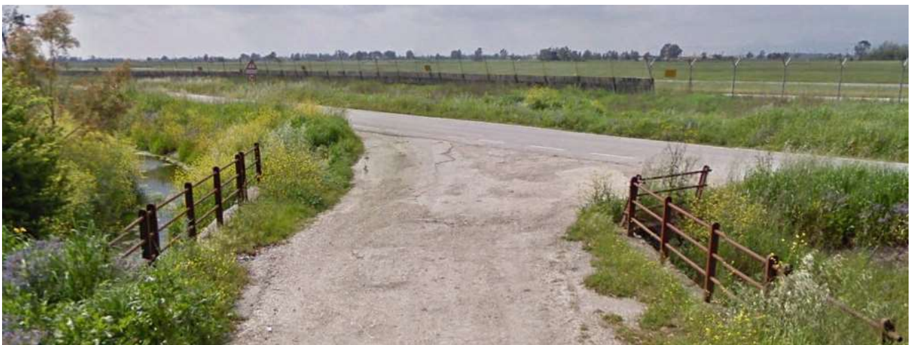
Figura 9: Interferenza Superficiale n.2 – Canali irrigui a cielo aperto
