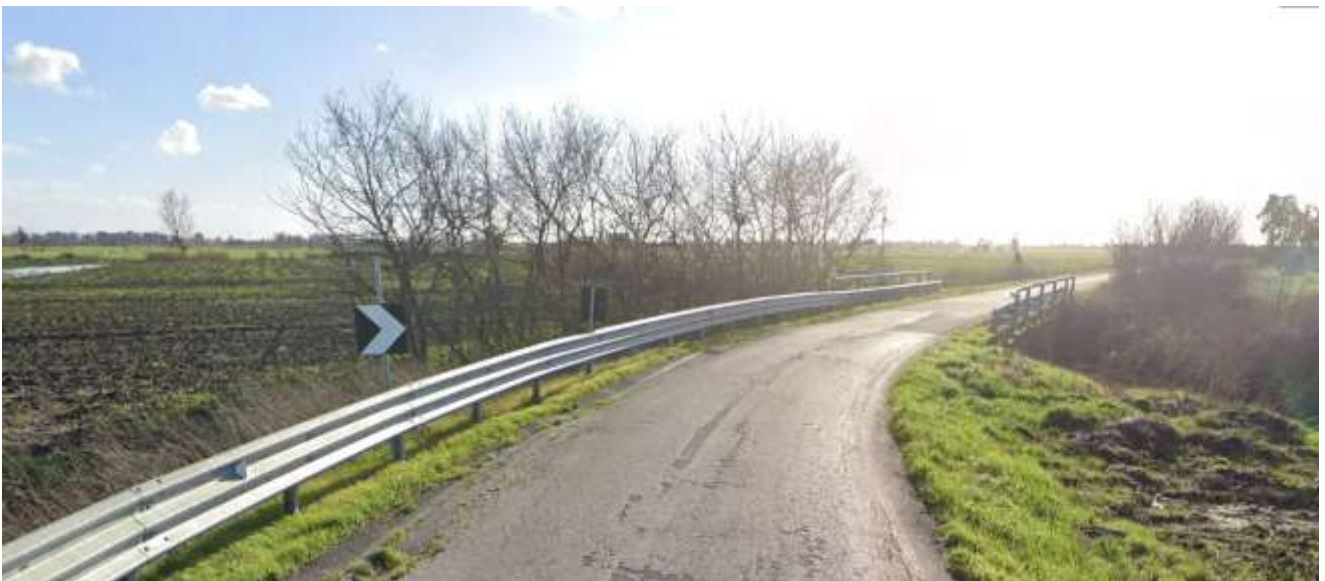
Figura 11: Interferenza Superficiale n.3 – Canali irrigui a cielo aperto
