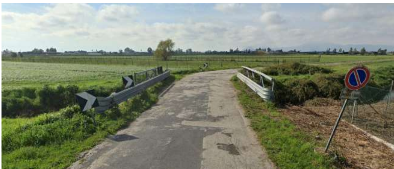
Figura 13: Interferenza Superficiale n.4 – Canali irrigui a cielo aperto
