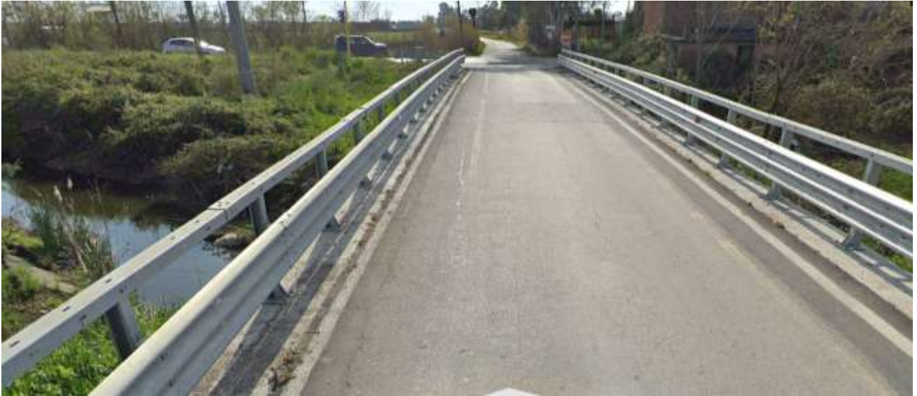
Figura 16: Interferenza Superficiale n.5 – Canali irrigui a cielo aperto
