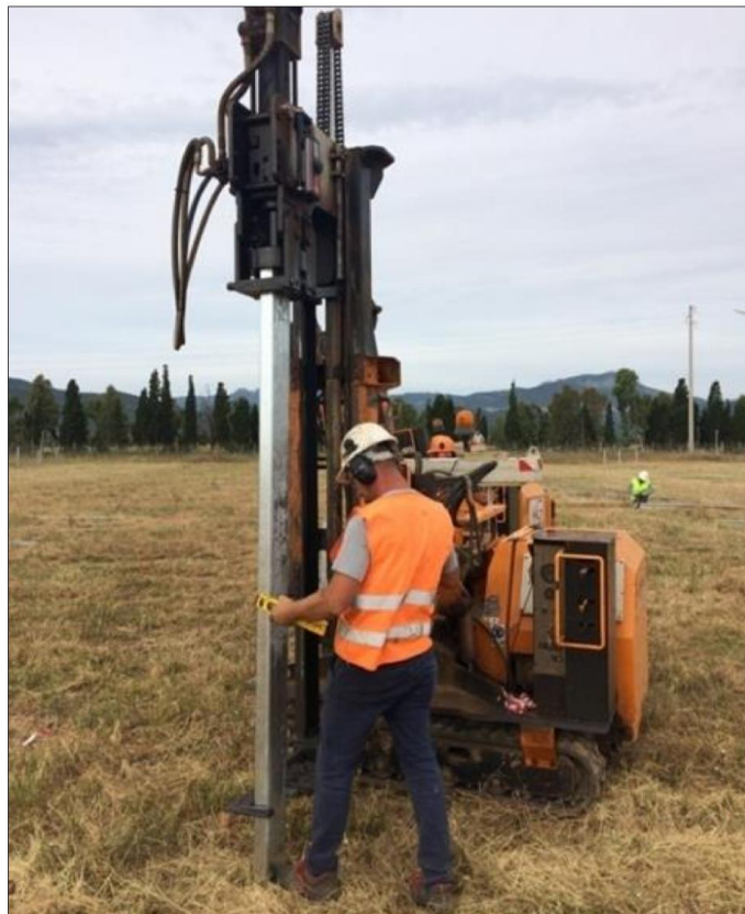
Figura 17: infissione delle strutture
