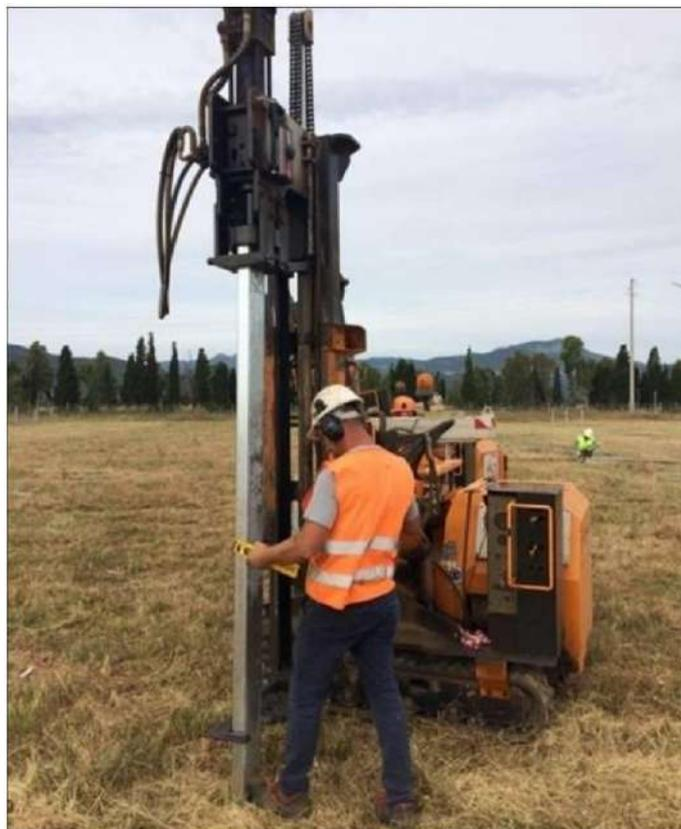
*Figura 15: infissione delle strutture*
