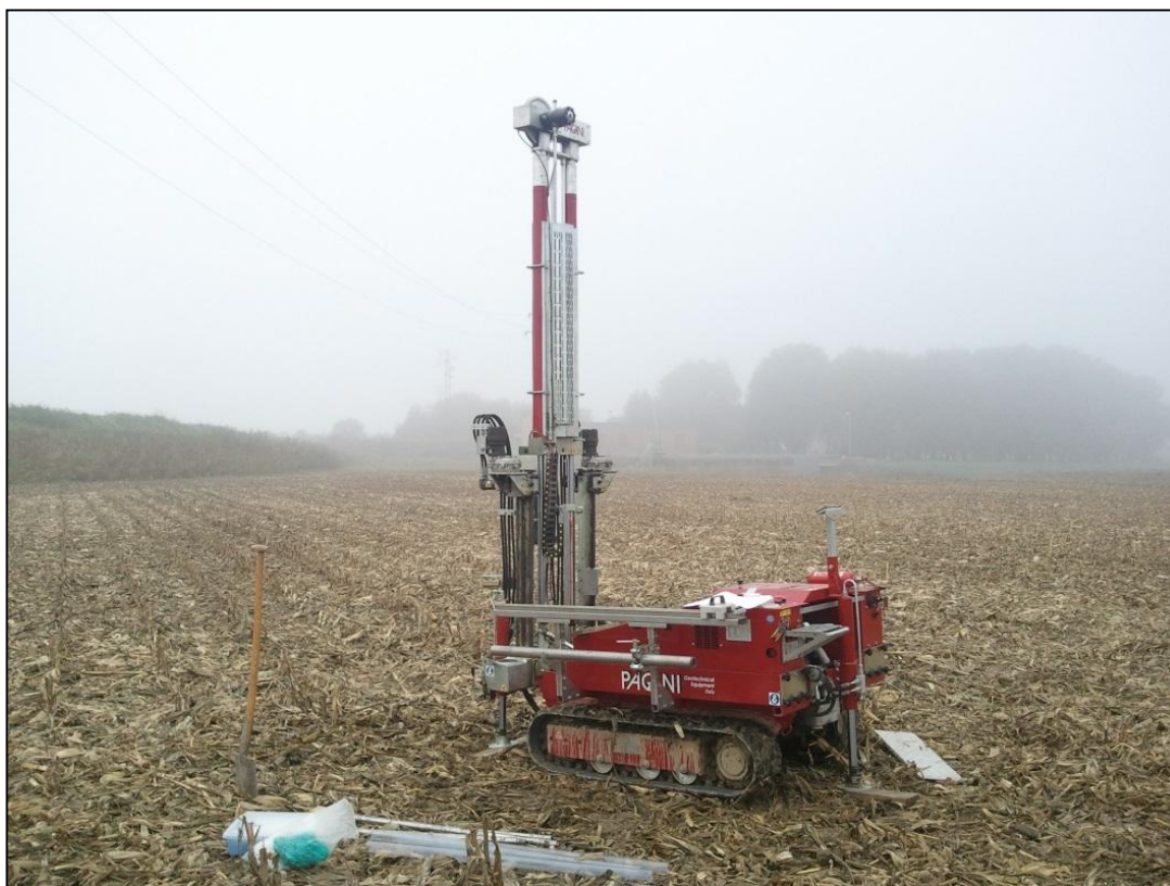
Esempio esecuzione sondaggio a carotaggio continuo
