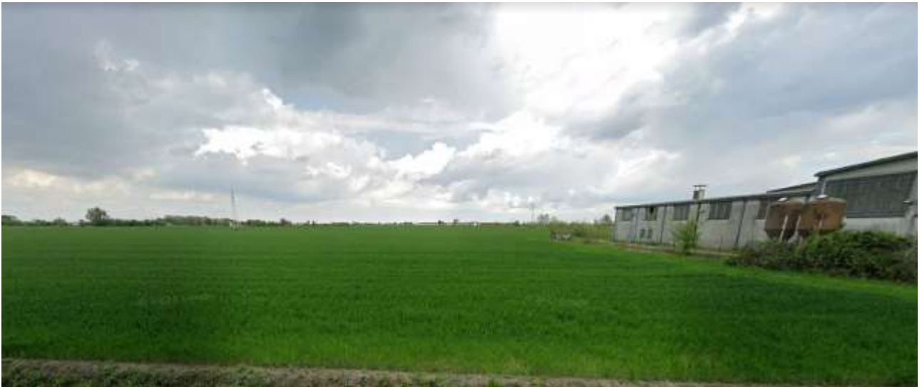
Foto 2 STATO attuale, vista da Via Tenuta Spalletti (ovest)
