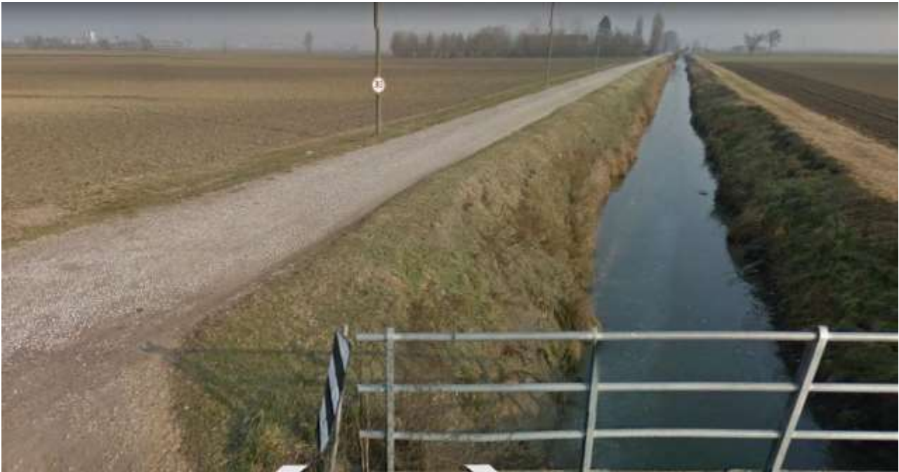
Foto 4 - STATO attuale, vista da Via Tenuta Spalletti su strada privata – Cavo Bentivoglio
