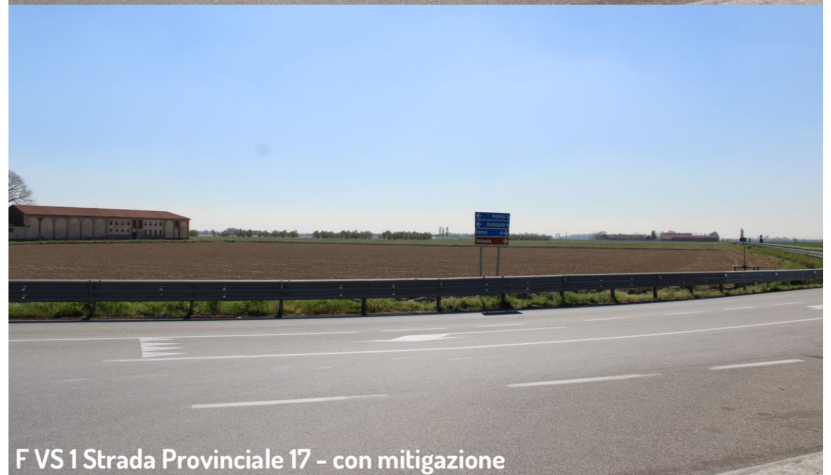
F VS 1 Strada Provinciale 17
