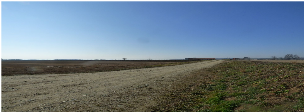
Area impianto Lotto 5 Campo Fontana e viabilità in pavimentazione naturale
