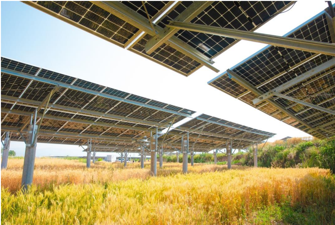
Figura 6. Frumento coltivato al di sotto dei pannelli fotovoltaici nelle campagne di Baoji (Cina, 2021) ( https://www.longi.com/us/news/6716/ )
