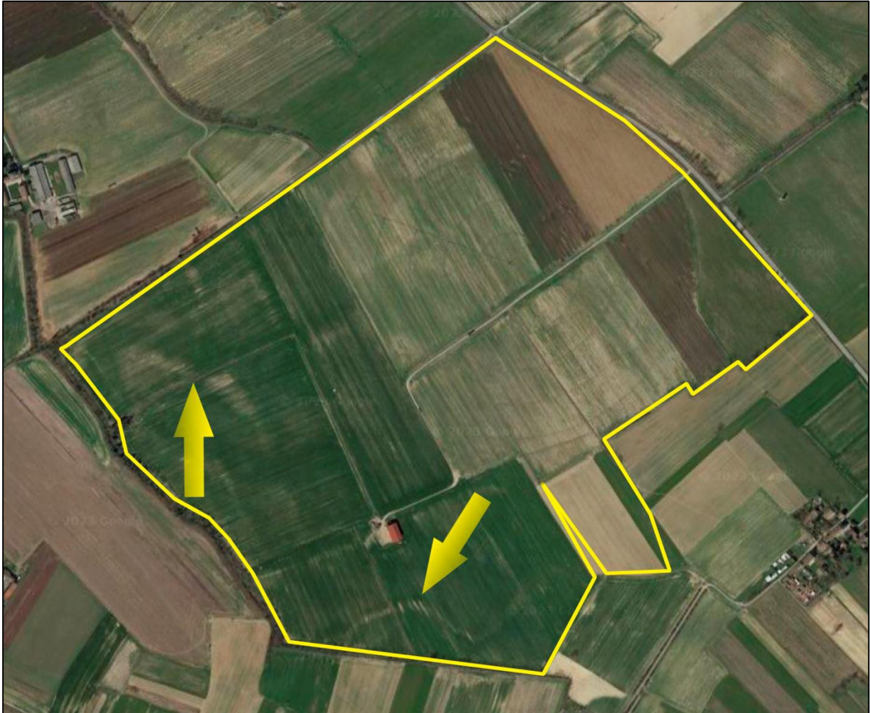
Figura 11. Posizionamento dell'area interessata dal progetto del parco fotovoltaico con indicazione di alcune anomalie. Foto satellitare da Google Maps (scatto del 2023).
