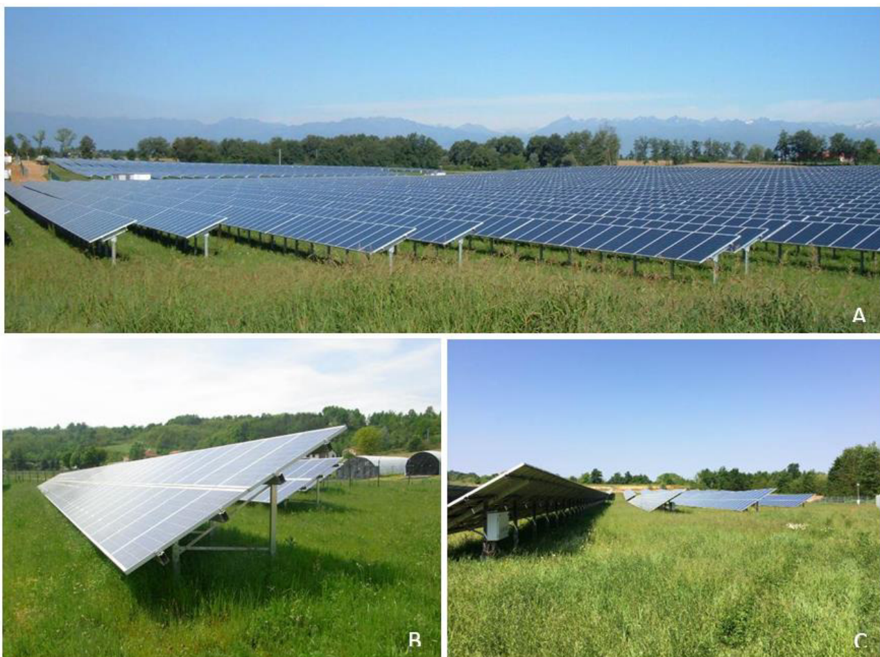
Figura 90. Immagini di grandi impianti fotovoltaici a terra (scattate dagli scriventi) riferite a progetti realizzati (anche con tecnologie differenti) che forniscono evidenza oggettiva dell'effetto non limitante dell'ombreggiamento generato per l'attività fotosintetica. A) Impianto FV "Ternavasso" – 7,5 MWp, Poirino (TO); B) Impianto FV "Cortiglione Green" – 0,8 MWp, Cortiglione (AT); C) Impianto FV "Sulpiano Cross" – 2,5 MWp, Montà (CN).
