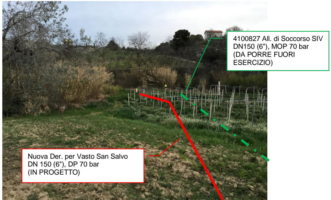
Foto n.19 – Km 6+605 - Panoramica metanodotti da porre fuori esercizio e in progetto
