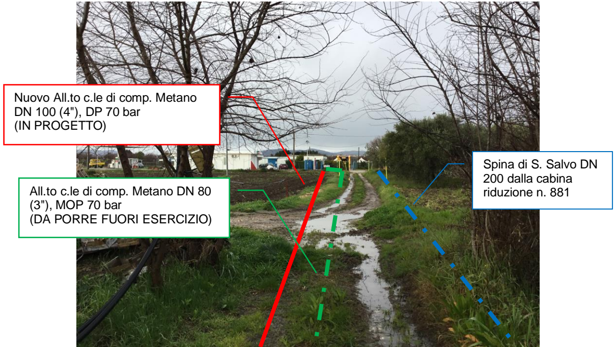
Foto n.29 – Km 8+700 - Vista metanodotti presso area di distribuzione metano
