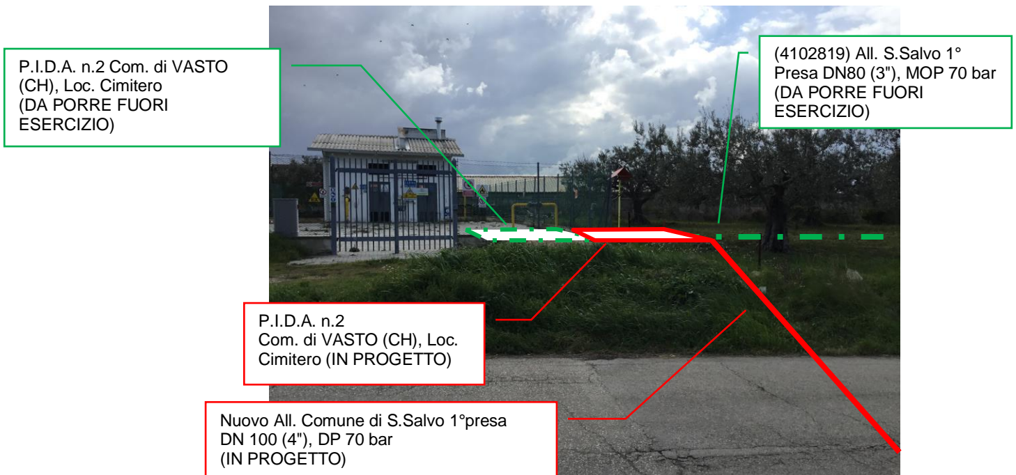
Foto n.32 – Km 0+475 - Area impianti e metanodotti da porre fuori esercizio e in progetto
