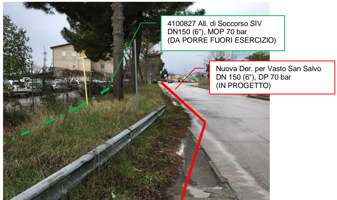
Foto n.26 – Km 8+492 - Percorrenza metanodotti su S.P. 200
