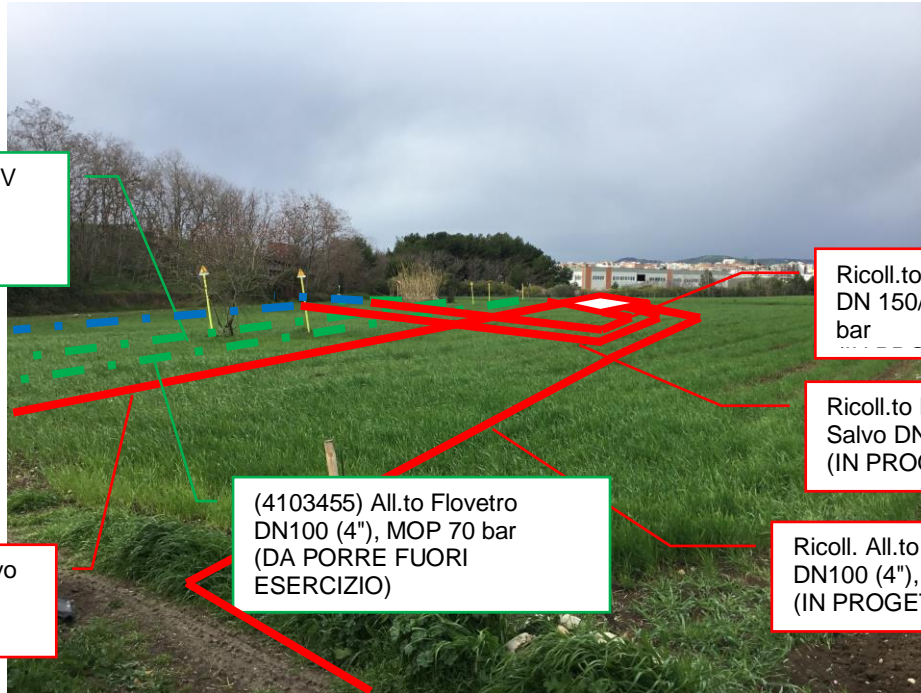
Foto n.23 – Km 8+000 - Panoramica metanodotti da porre fuori esercizio e in progetto
