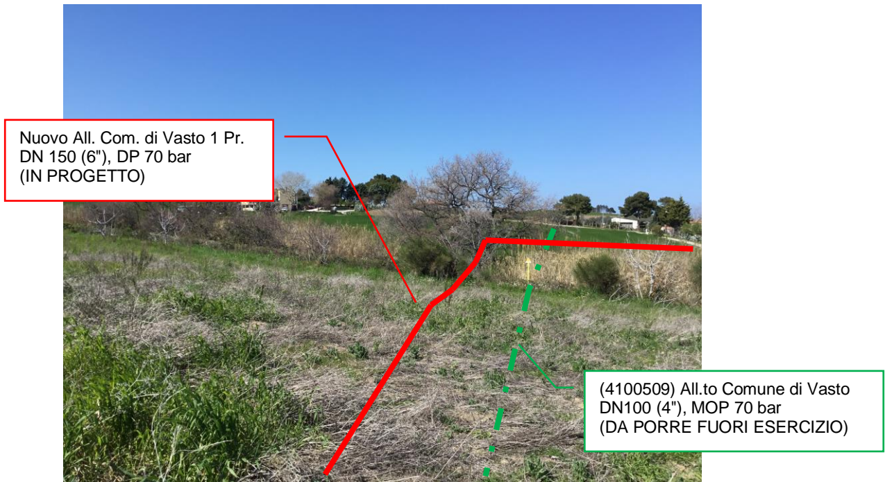
Foto n.3 – Km 0+700 - Panoramica metanodotti in progetto e da porre fuori esercizio
