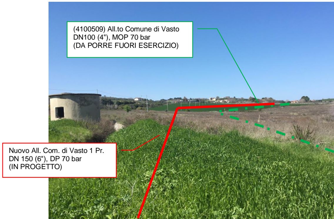
Foto n.1 – Km 0+210 - Panoramica metanodotti in progetto e da porre fuori esercizio
