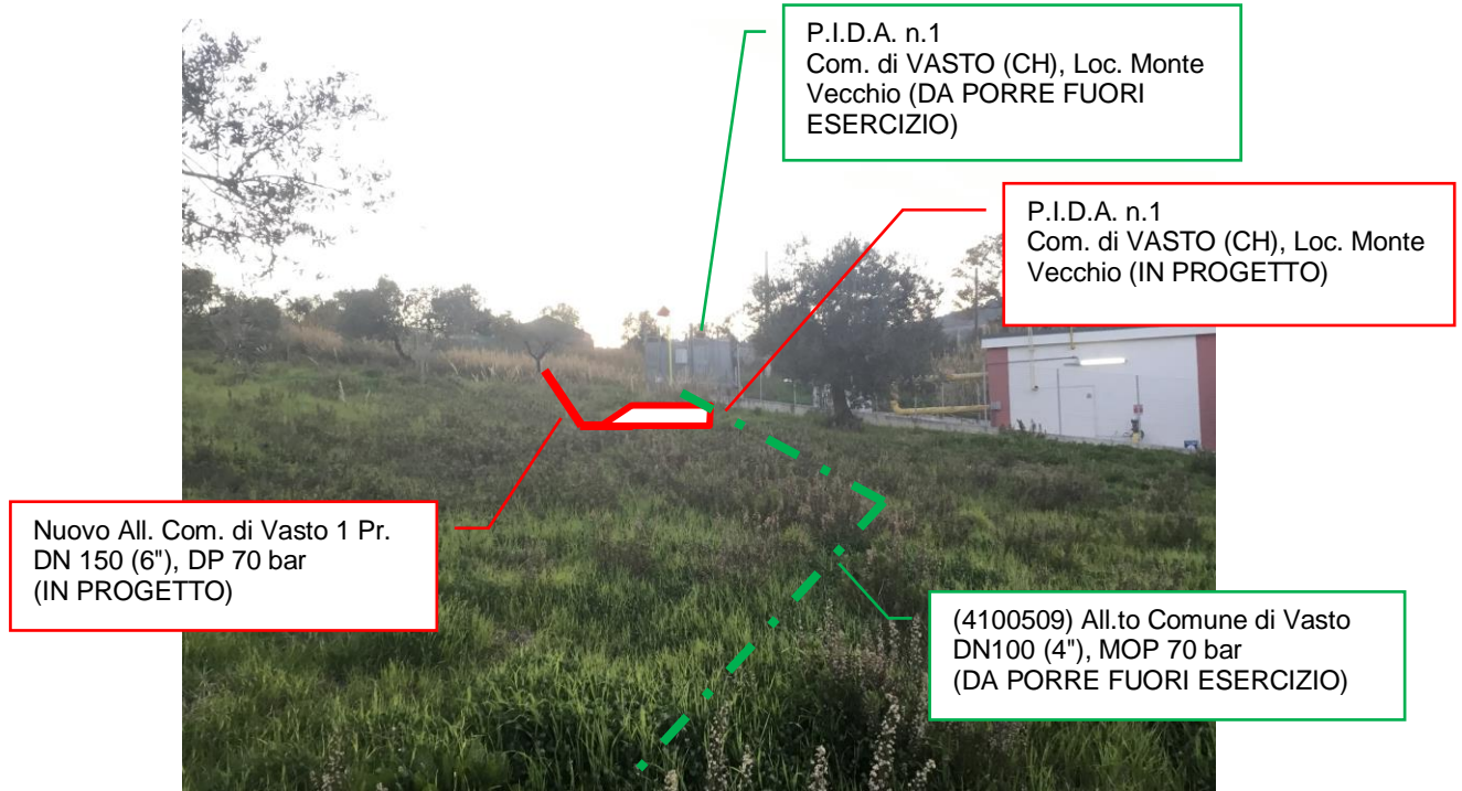
Foto n.11 – Km 4+650 - Area impianto PIDA da porre fuori esercizio e PIDA in progetto e Nuovo All. Com. di Vasto 1 Pr. DN 150 (6"), DP 70 bar (IN PROGETTO)
