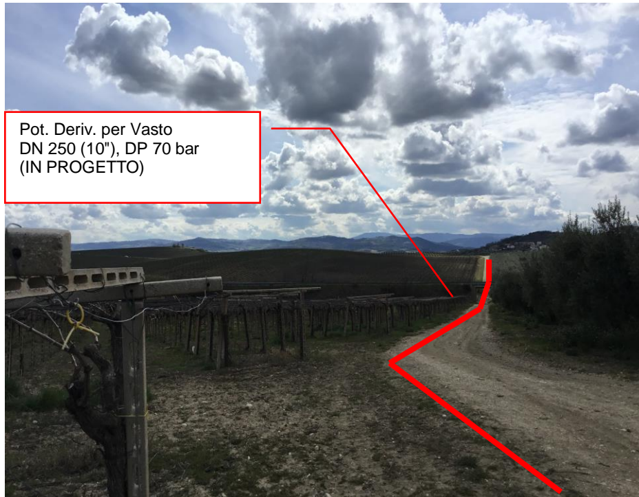
Foto n.7 – Km 1+652 - Panoramica Pot. Der. per Vasto DN 250 (10'') DP 70 bar (IN PROGETTO)
