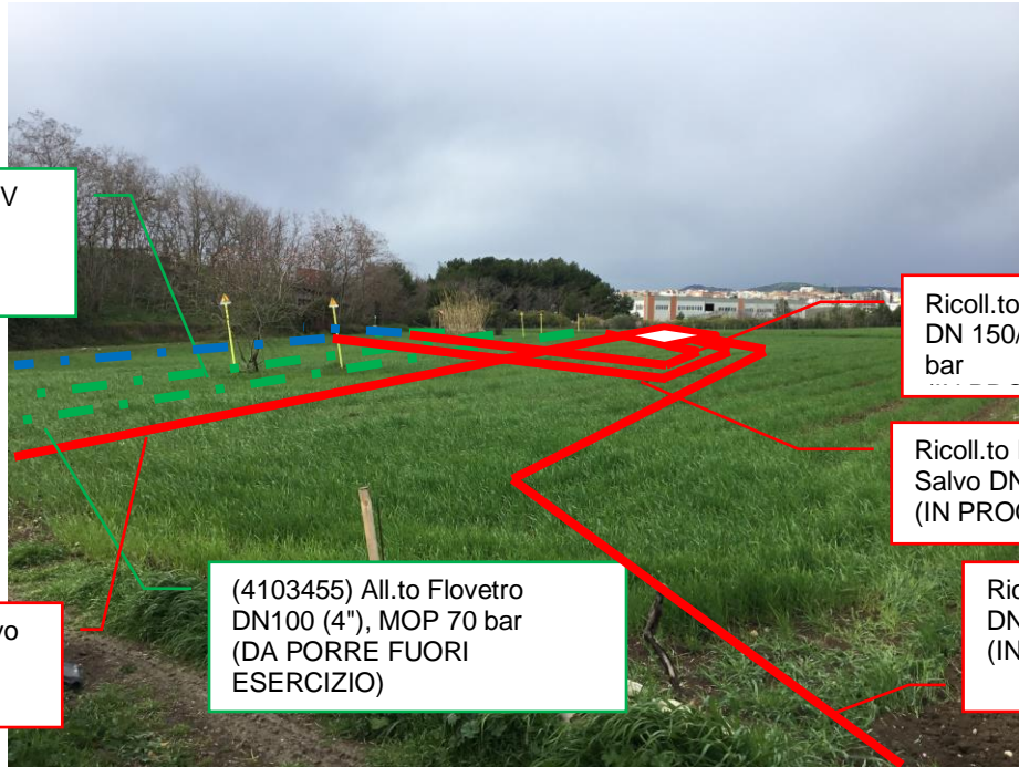
Foto n.16 – Km 2+018 - Panoramica metanodotti da porre fuori esercizio e in progetto
