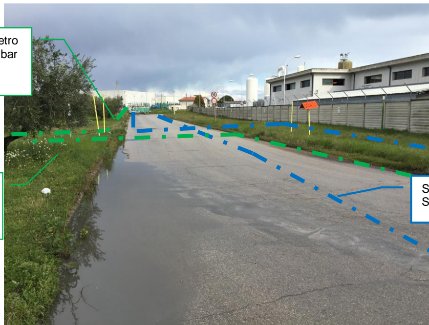
Foto n.17 – Km 2+087 - Percorrenza metanodotti su contrada Piane S. Angelo S.P. 200
