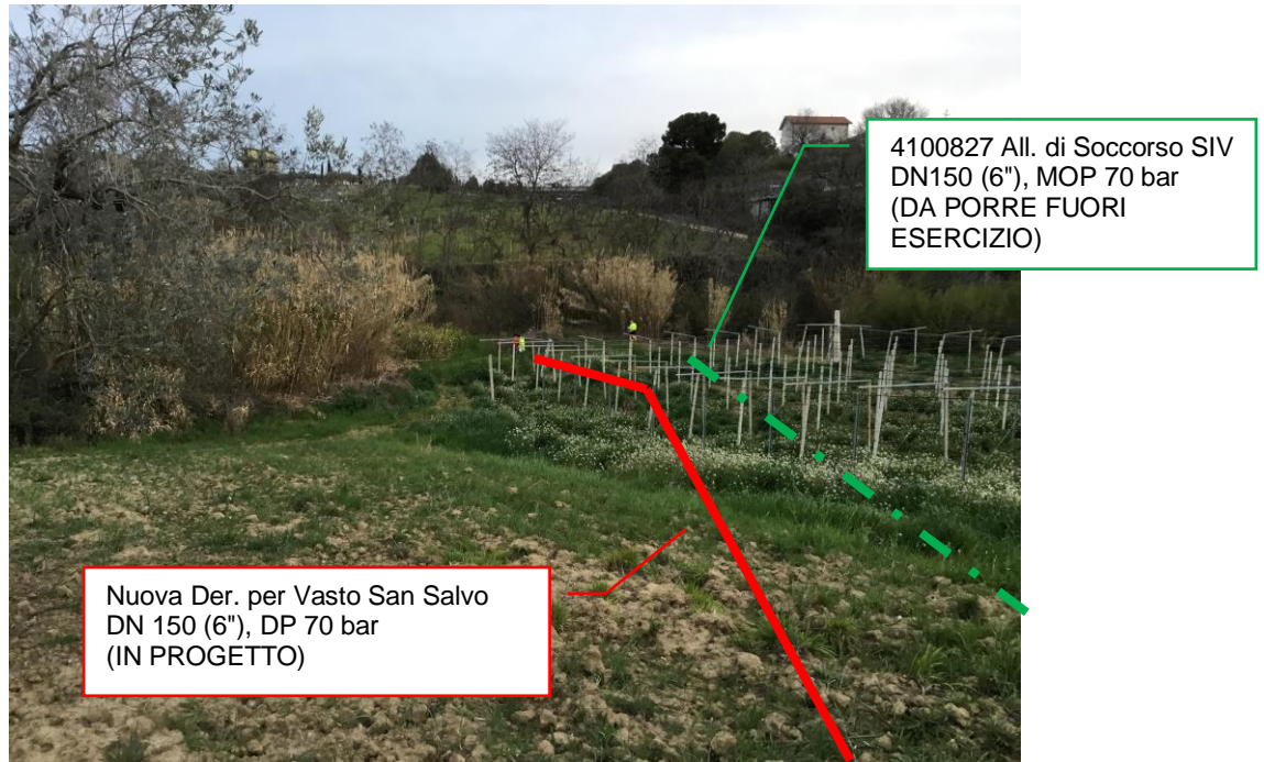
Foto n.12 – Km 0+658 - Panoramica metanodotti da porre fuori esercizio e in progetto
