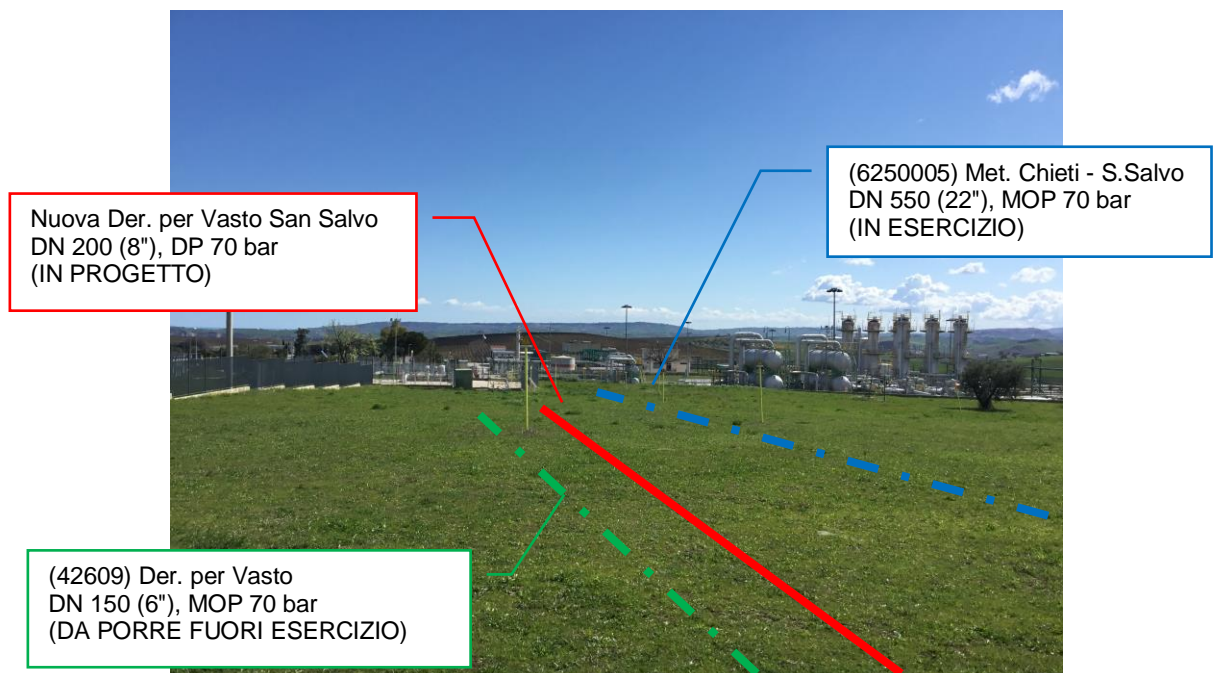
Foto n.2 – Km 0+060 Panoramica metanodotti esistenti, da porre fuori esercizio e in progetto
