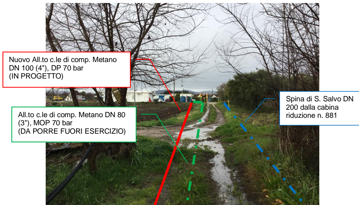
Foto n.22 – Km 2+716 - Vista metanodotti presso area di distribuzione metano
