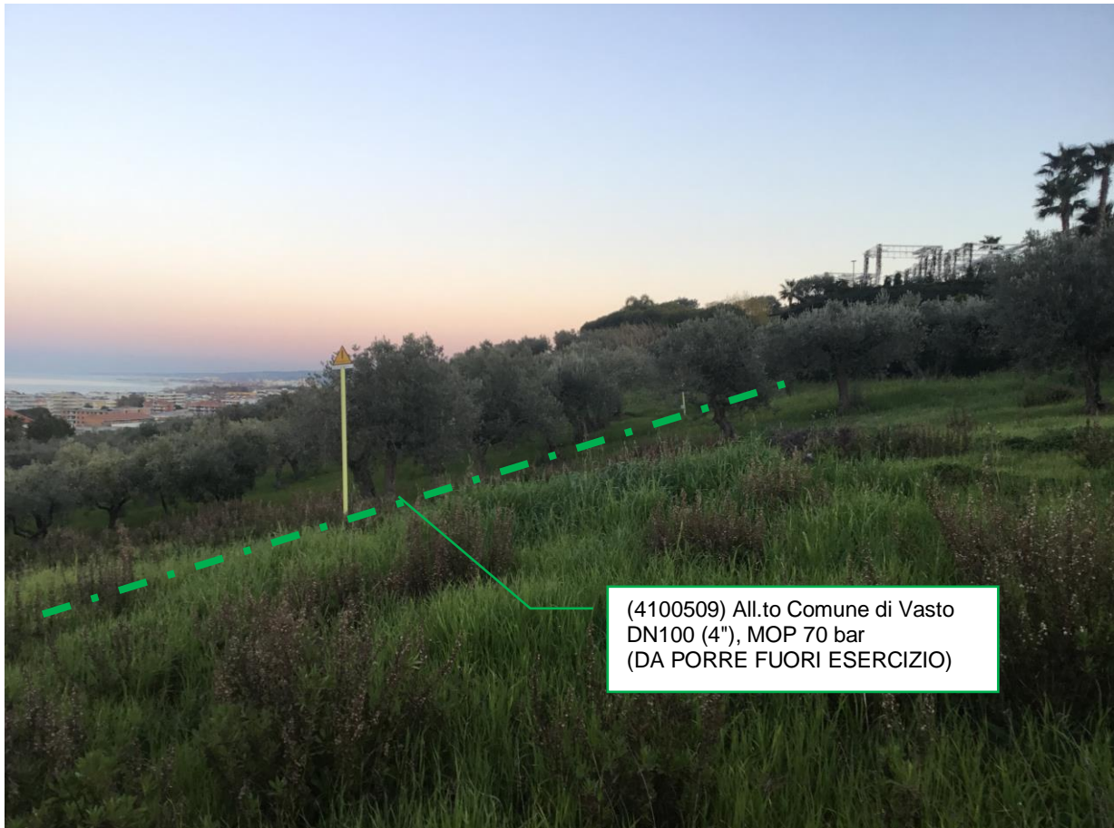
Foto n.10 – Km 3+750 - All.to Comune di Vasto DN100 (4''), MOP 70 bar (DA PORRE FUORI ESERCIZIO)
