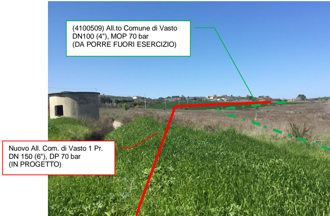
Foto n.1 – Km 0+010 - Panoramica metanodotti in progetto e da porre fuori esercizio
