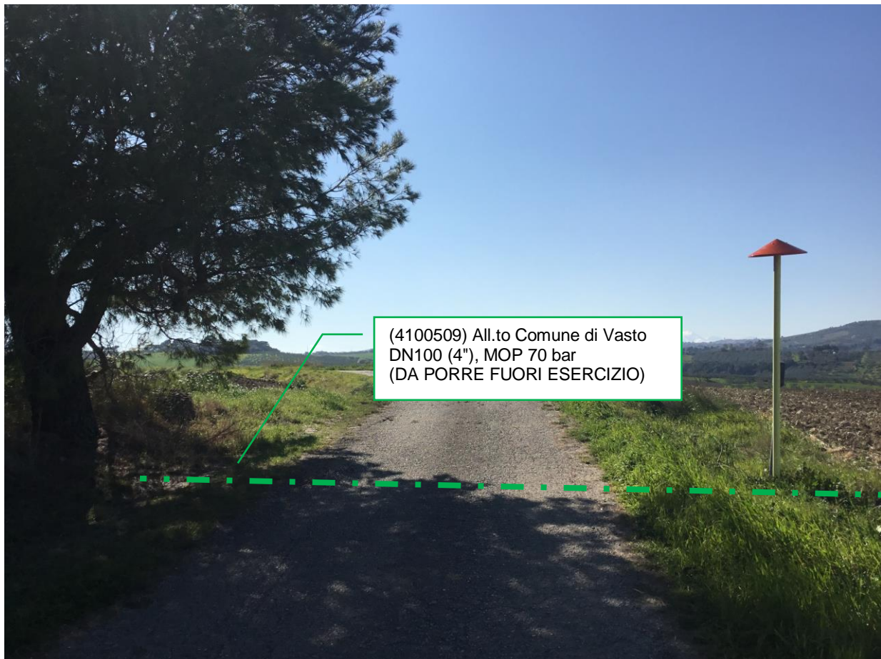
Foto n.7 – Km 1+700 - Metanodotto da porre fuori esercizio – 1° attraversamento su strada Via Selvotta
