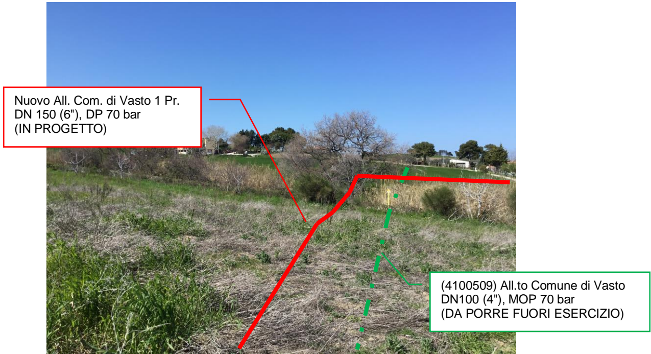
Foto n.3 – Km 0+492 - Panoramica metanodotti in progetto e da porre fuori esercizio
