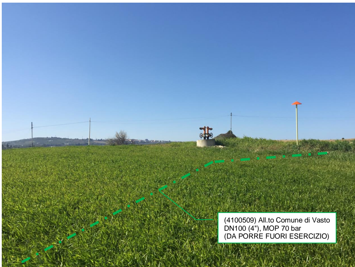
Foto n.6 – Km 1+354 - All.to Comune di Vasto DN100 (4''), MOP 70 bar (DA PORRE FUORI ESERCIZIO)
