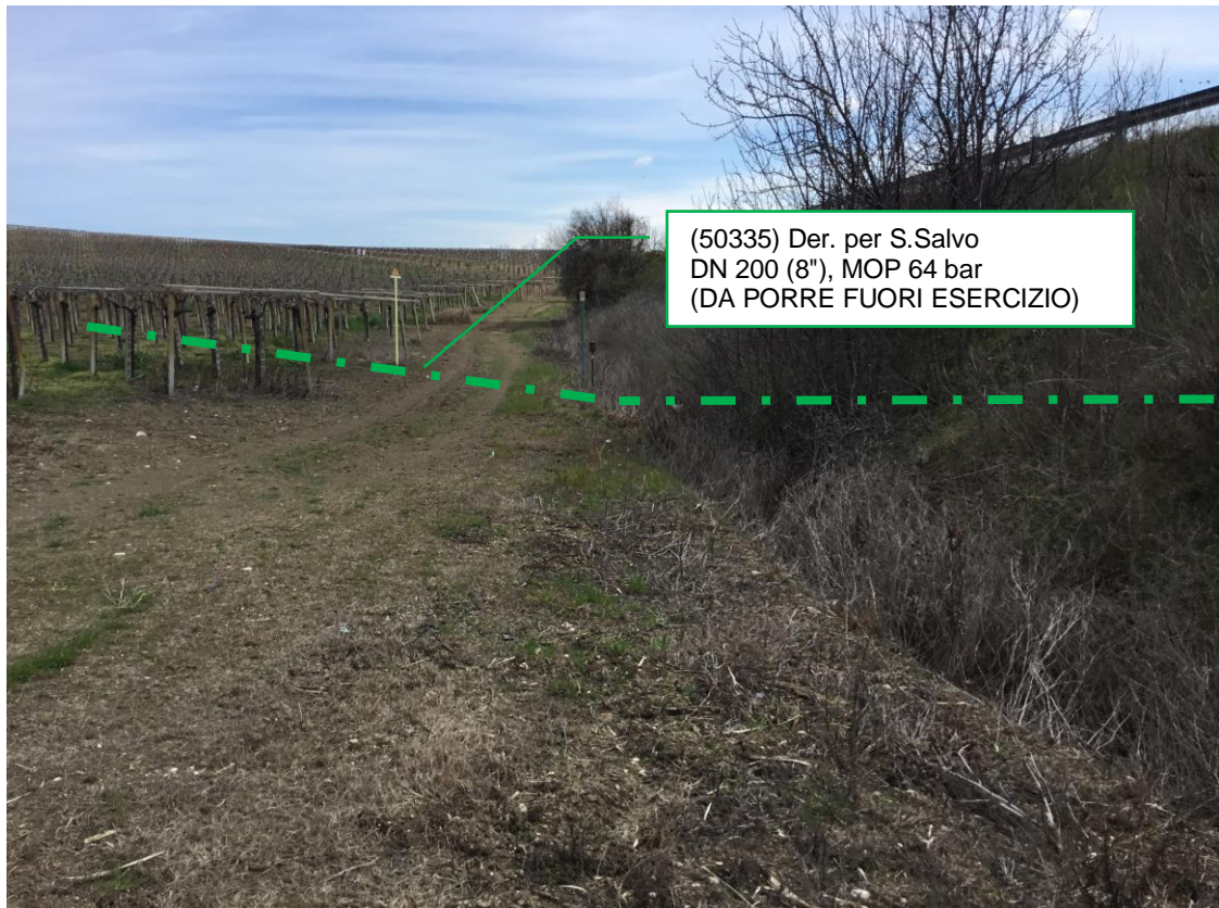
Foto n.4 – Km 1+161 - Attraversamento su strada asfaltata in rilevato del Met. Der. Per S.Salvo DN 200 (8") da porre fuori esercizio.
