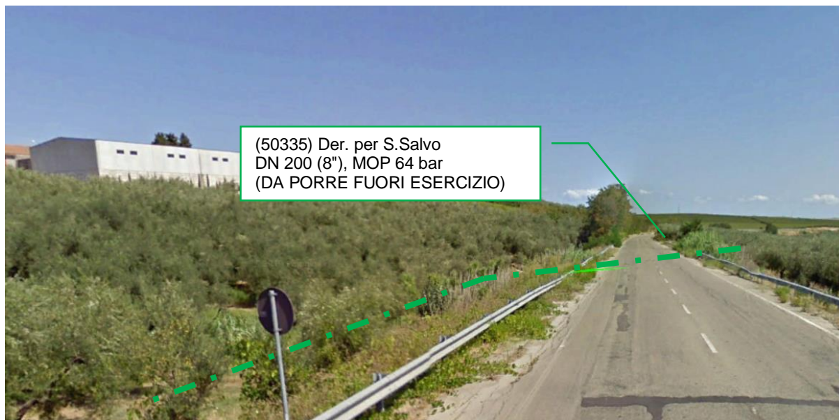
Foto n.3 – Km 0+450 - Attraversamento su strada asfaltata in rilevato del Met. Der. Per S.Salvo DN 200 (8”) da porre fuori esercizio.
