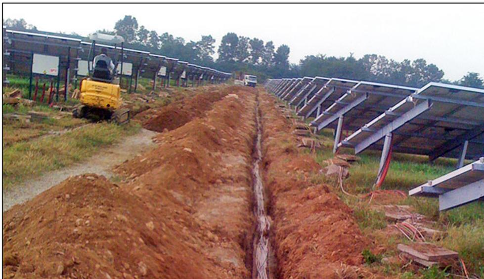
Figura 1 – Tipico di scavo per cavi BT/MT
