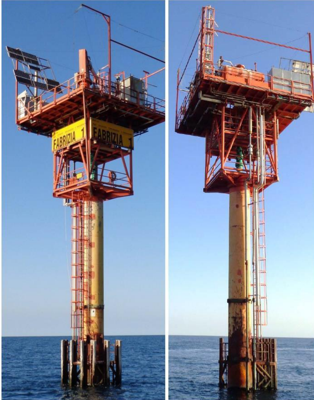
Figura 1-2: Vista generale della Piattaforma Fabrizia 1 (fonte: Eni)
