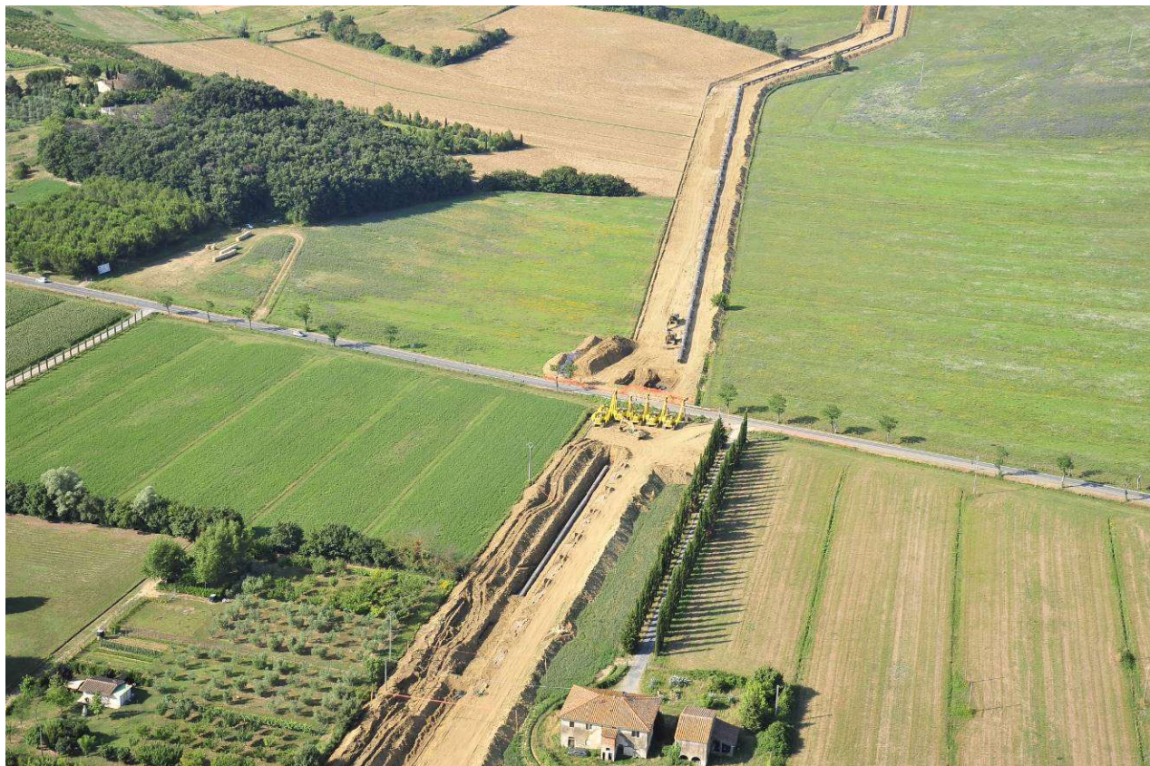
Fig. 4.4 – Panoramica dell’area di un tratto di metanodotto soggetto a TOC per l’attraversamento di un’infrastruttura viaria.
