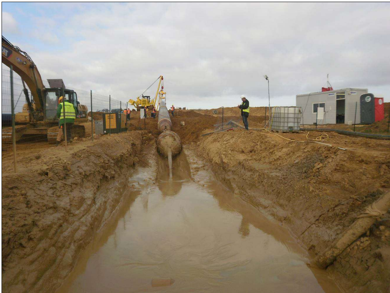
Fig. 4.6 – Fase di “tiro – posa della condotta”.
