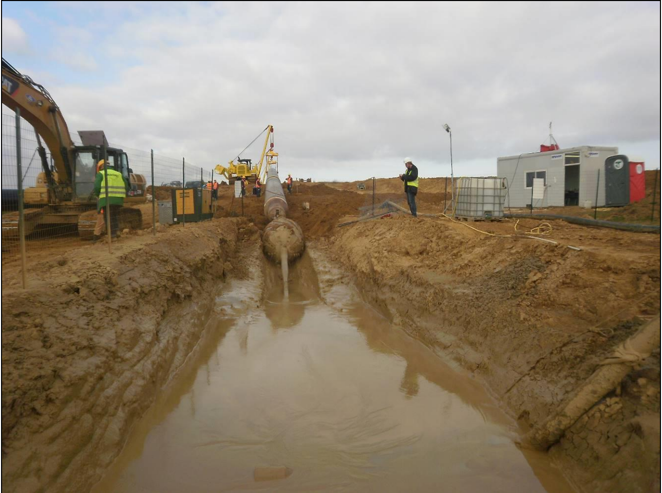
Fig. 5.4 – Fase di “tiro – posa della condotta”.
