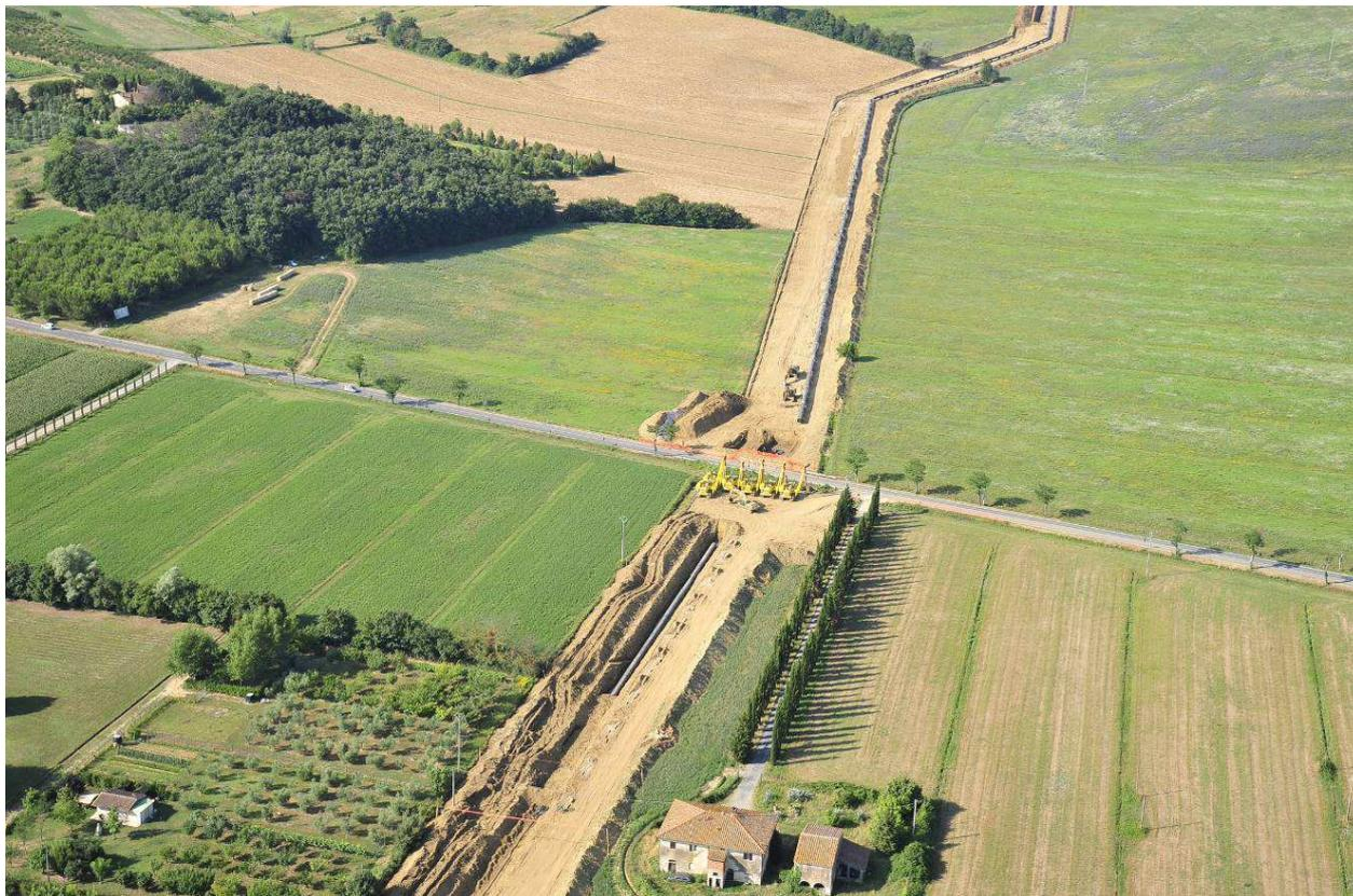
**Figura 2 - Panoramica dell'area di un tratto di metanodotto soggetto a TOC per l'attraversamento di un'infrastruttura viaria.**
