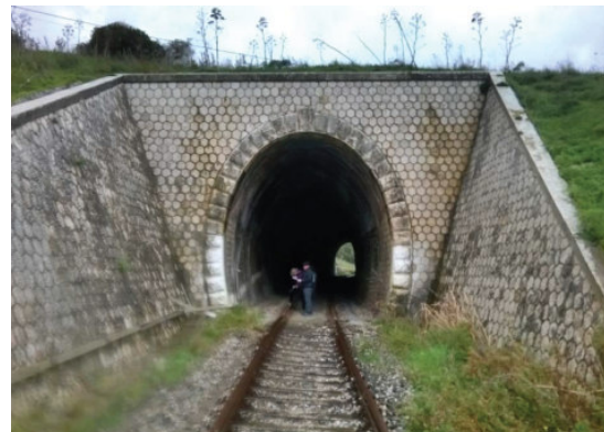
Figura 2-3 Sezione di progetto delle gallerie e imbocco con rivestimento in blocchi di pietra squadrata
