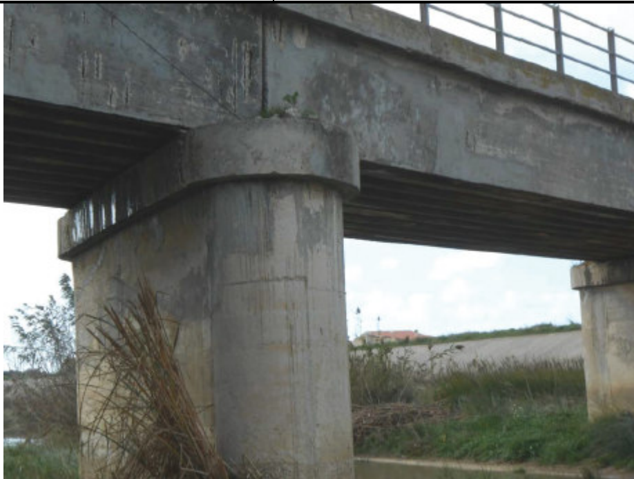
Figura 2-4 Viadotto in calcestruzzo di attraversamento del canale di Xitta
