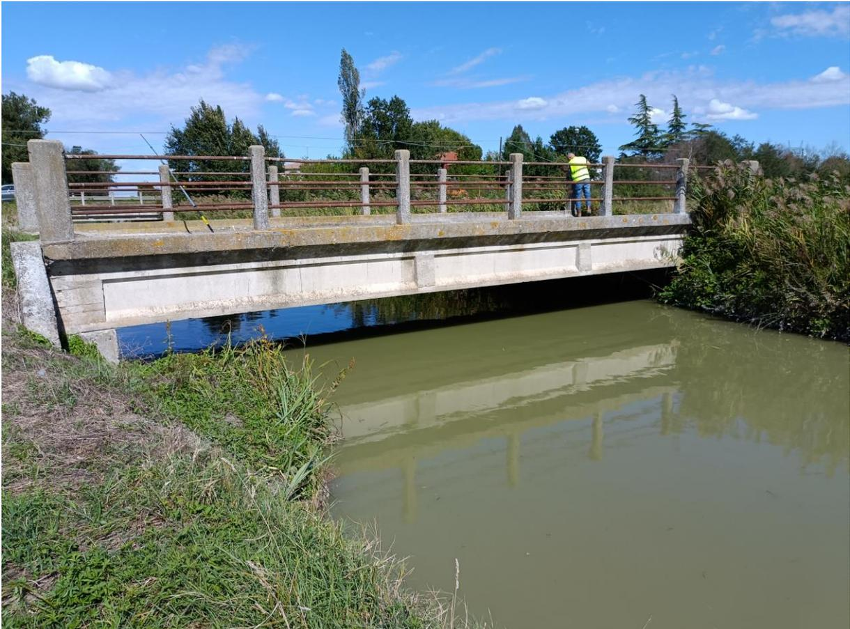
**Figura 6.1/E: Foto del punto critico 2 da cui si evince che la presenza del ponte non ostruisce/modifica la sezione dell'alveo, per cui non crea ostacolo al deflusso delle acque.**
