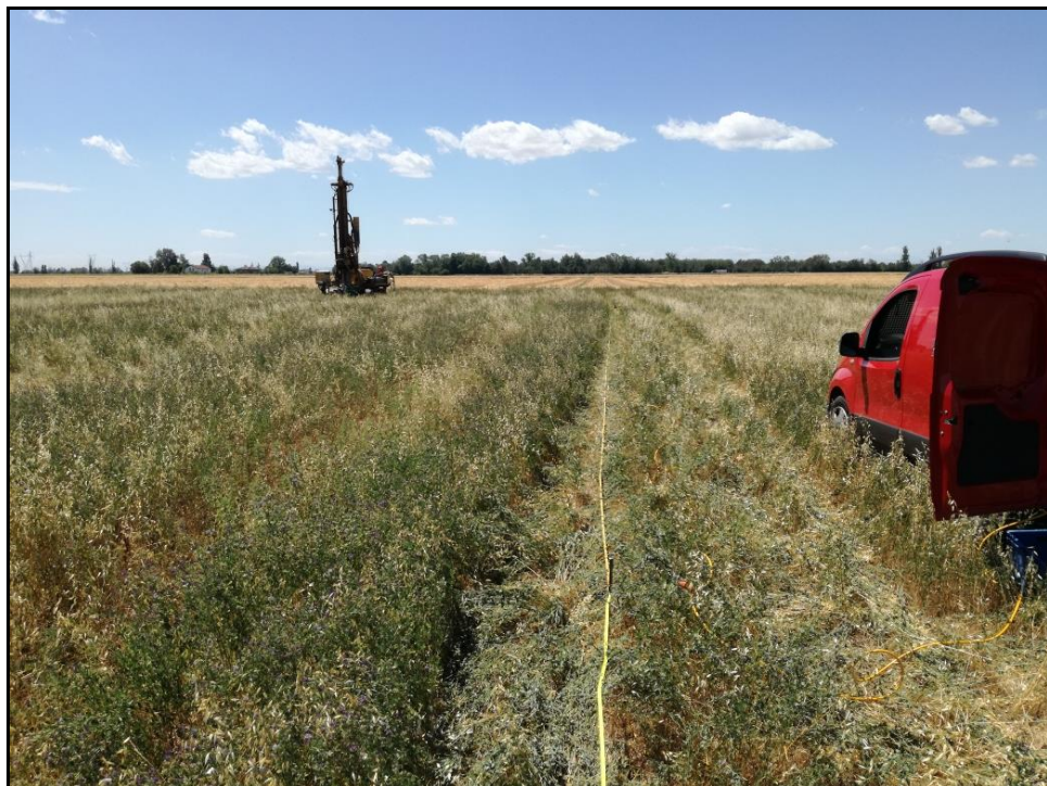
Figura 20 - Vista dello stendimento MASW M2.
