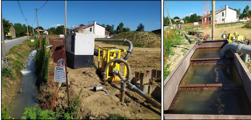
Figura 4.3: Vasche di decantazione utilizzate per eliminare i sedimenti in sospensione derivanti dalle acque di aggotamento
