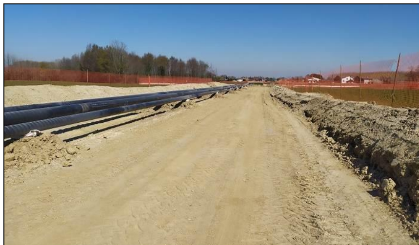
Figura 7.2: Esempio di accantamento dello scotico ai lati della pista di lavoro.
