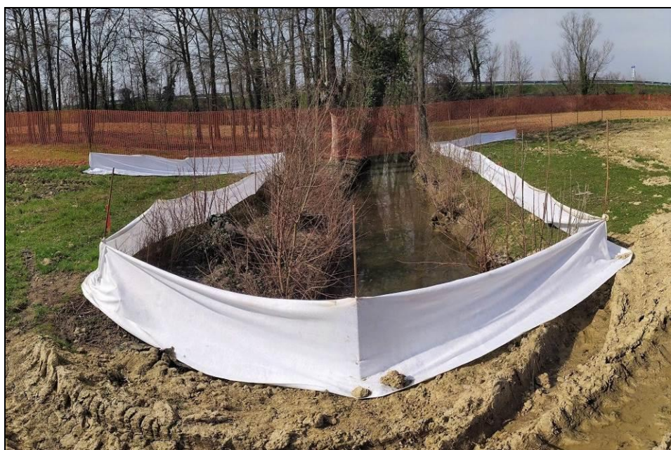
Figura 7.3: Esempio di un'installazione di barriere anti-intrusione per l'erpetofauna
