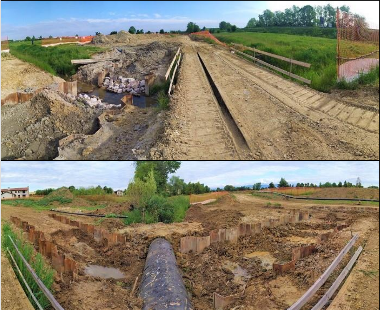
Figura 4.1: Esempi di bypass idrici realizzati
