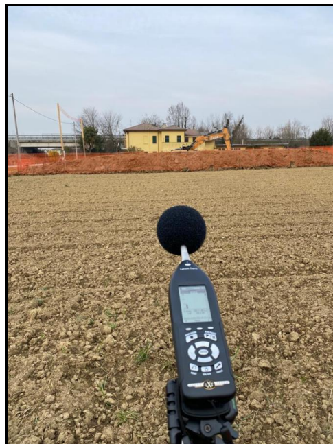
Vista dalla Postazione 3 dell'area di cantiere e della banchetta fonoassorbente
