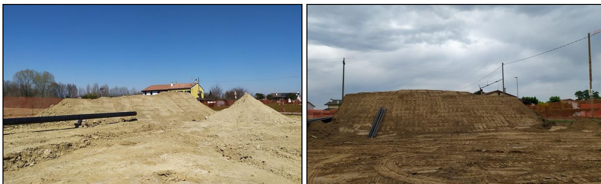
Figura 3.5.4 - Tipologie di barriere acustiche installate
