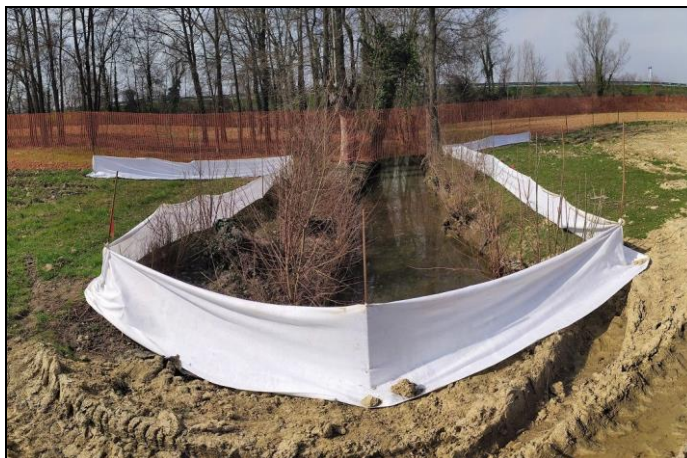
Figura 3.3.4/A - Esempio di un'installazione di barriere anti-intrusione per l'erpetofauna
