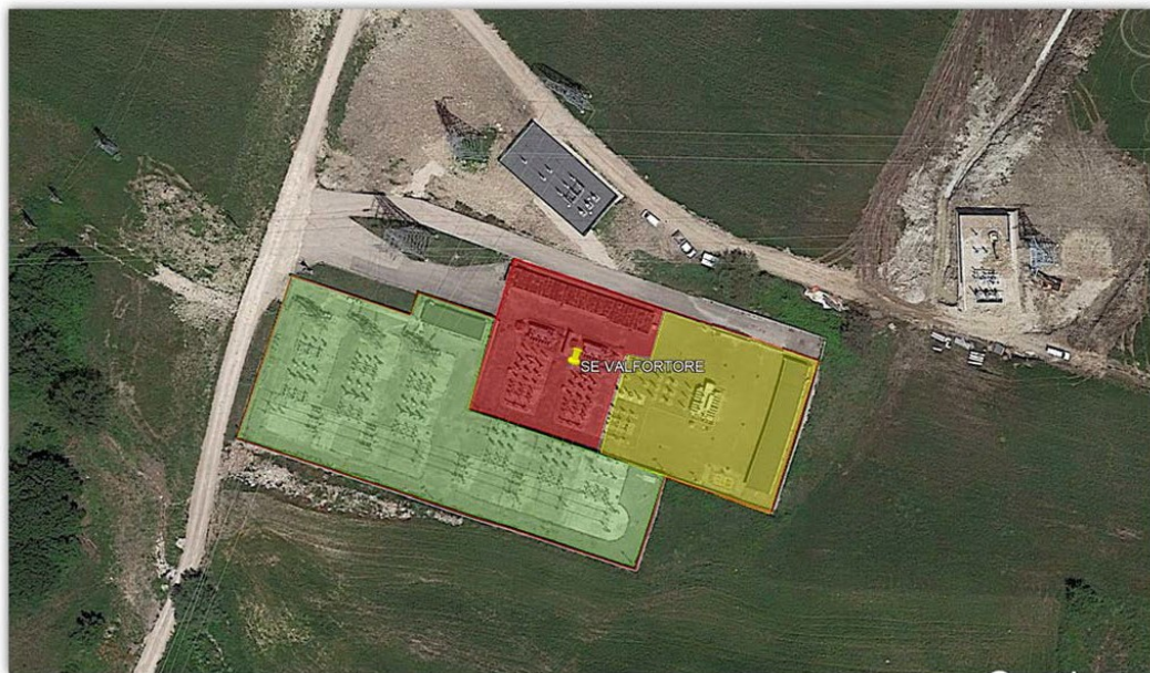
Figure 8:immagine satellitare stazione elettrica Val Fortore
