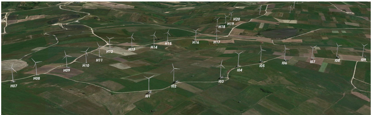
Layout impianto da dismettere -Aerogeneratori presenti nel territorio comunale di San Giorgio La Molarà
