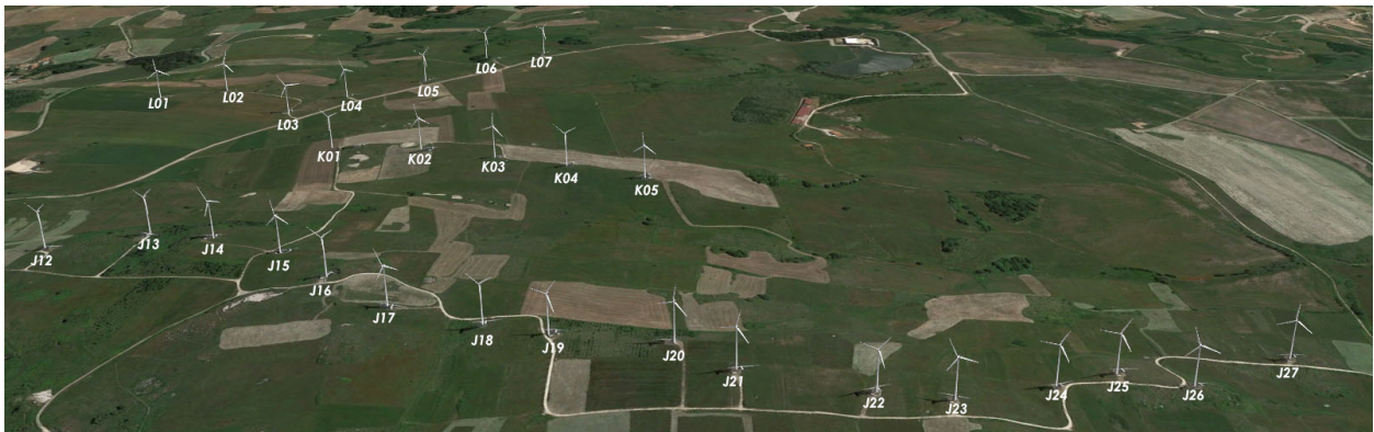
Layout impianto da dismettere -Aerogeneratori presenti nei territori comunali di Baselice, Foiano di Val Fortore e San Marco dei Cavoti
