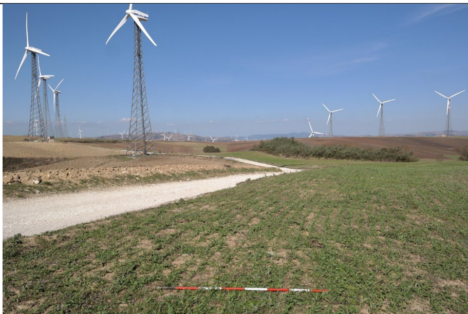
Foto 2: cavidotto in strada comunale Rossanello nei pressi di SGM02. Vista da sud
