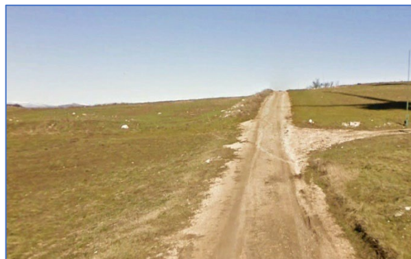
Foto 4: Cavidotto di collegamento tra SMC04-SMC05 vista da sud
