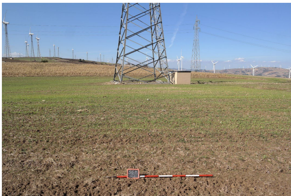
Foto 3: area con seminativo basso nella sede dell'aerogeneratore SGM02. Vista da sud
