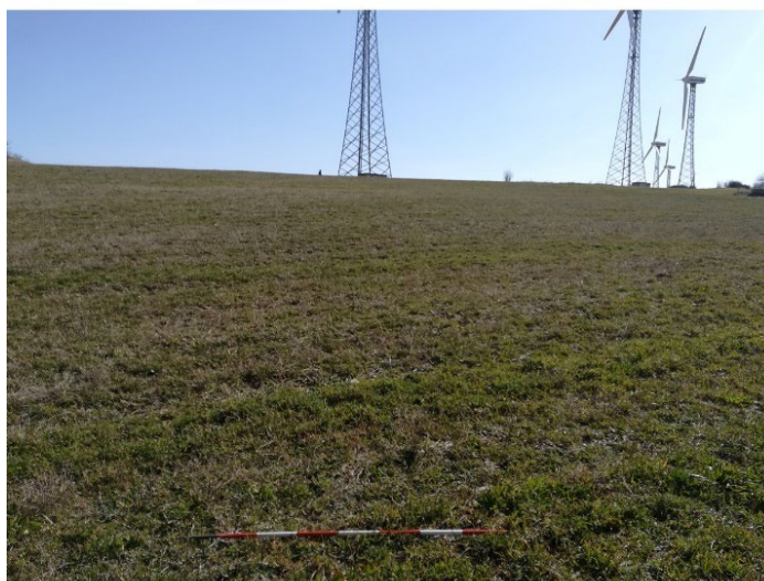
Foto 01-02-03 aerogeneratore MOL01 e cavidotto annesso
