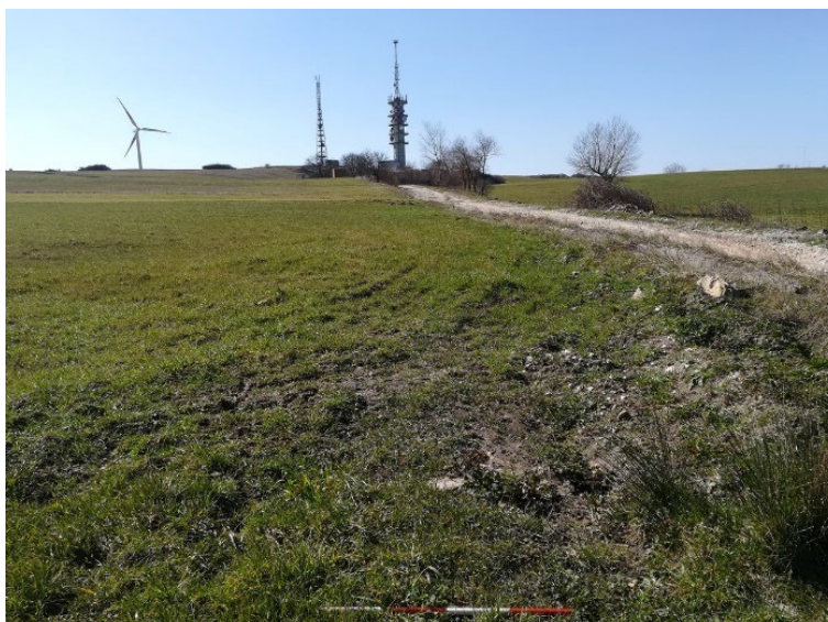
Foto 7-12 cavidotto lungo la strada sterrata sulla sommità del colle
