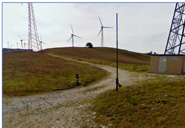
Foto 3: Campo- aerogeneratore BAS02, vista da nord
