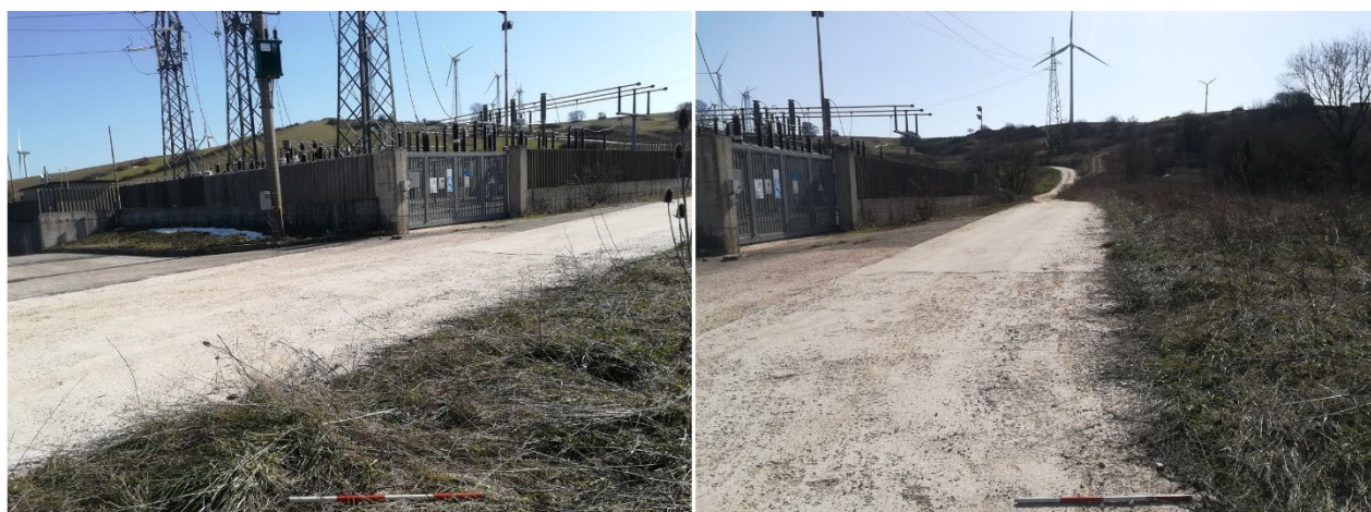
Foto 13-14 area di sottostazione esistente e cavidotto
