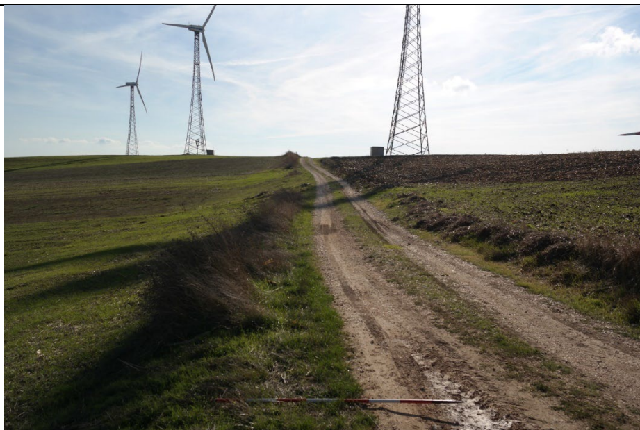
Foto 19: cavidotto in strada vicinale Crocelle nei pressi di SGM04. Vista da est
