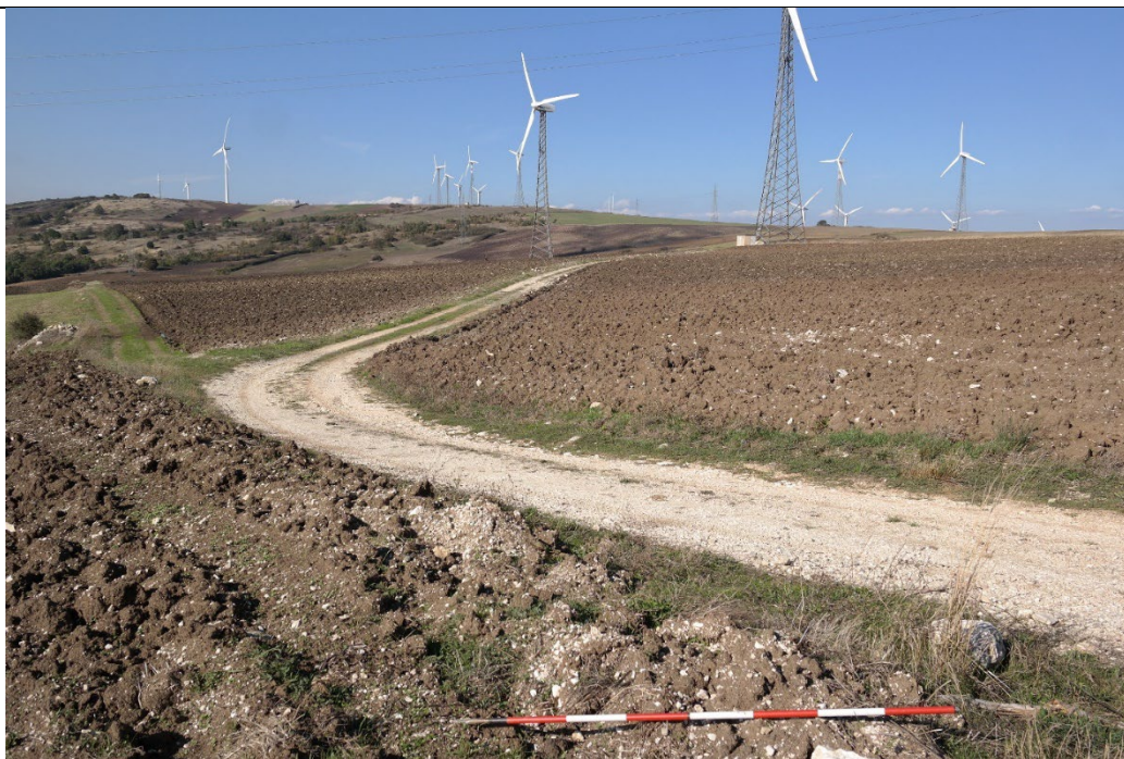
Foto 2: cavidotto in strada vicinale Crocelle nei pressi di SGM04. Vista da sud
