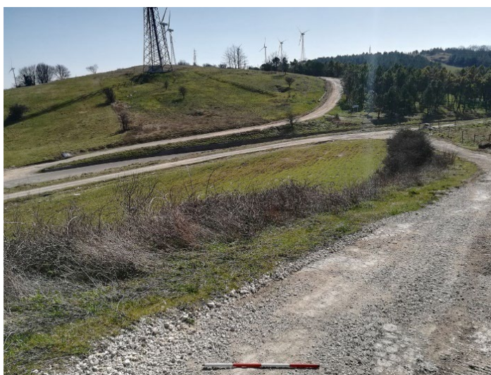
Foto 3-4 cavidotto in uscita da Mol02 verso il fondo del colle, attraversando SS369
