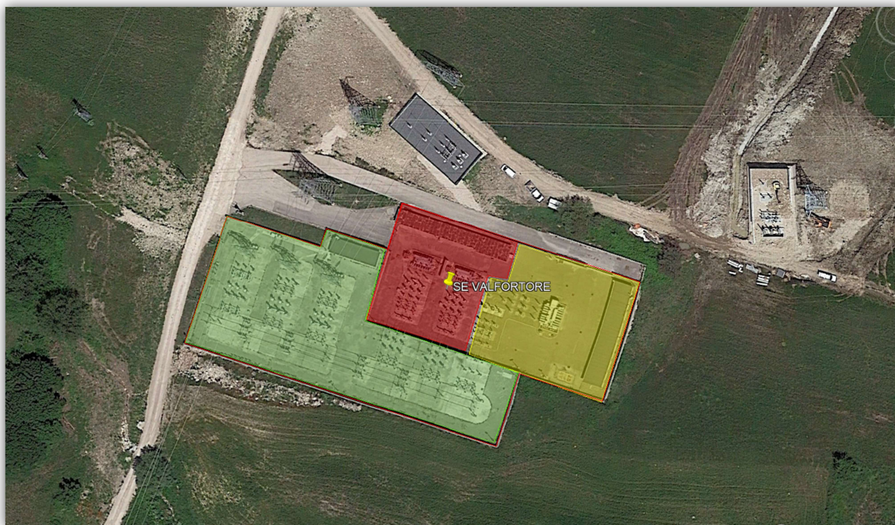
Fig. 3. Inquadramento su ortofoto del punto di connessione: in rosso la SSE esistente con i suoi stalli AT oggetto di adeguamento di potenza e di tensione sul lato MT, che passa da 20 a 30kV. Anche i locali tecnici saranno rinnovati. In verde l'area TERNA; in giallo la SSE di altro produttore.
