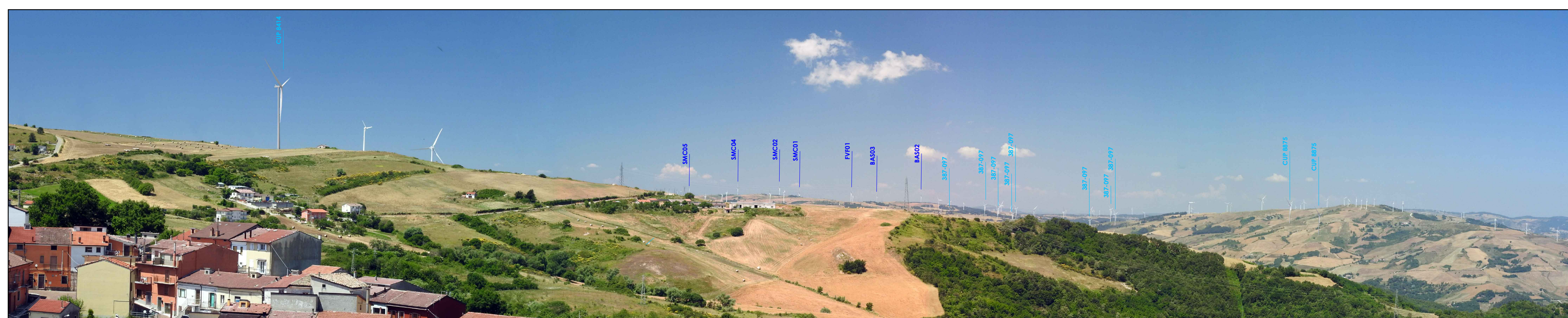
AEROGENERATORI IVPC DI PROGETTO AEROGENERATORI TERZI AUTORIZZATI CON CODICE IDENTIFICATIVO COME DA ANAGRAFE FER
