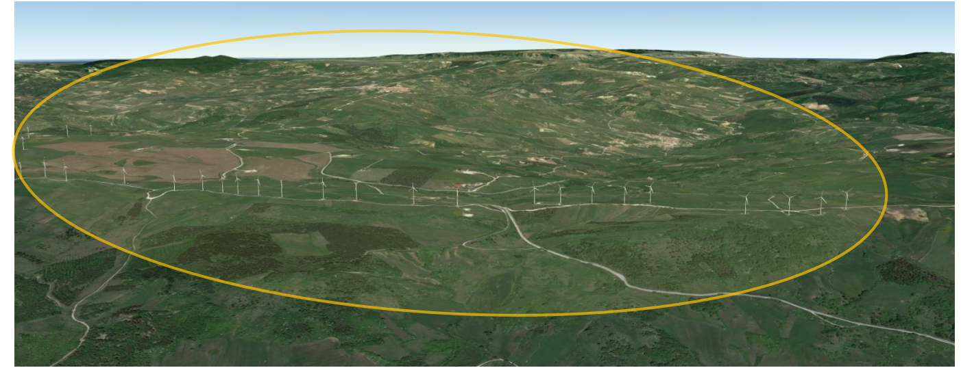
Stralcio Google Earth delle aree dei territori comunali di San Marco dei Cavoti, Molina, San Giorgio La Molara interessate dal Progetto - Individuazione aerogeneratori esistenti
