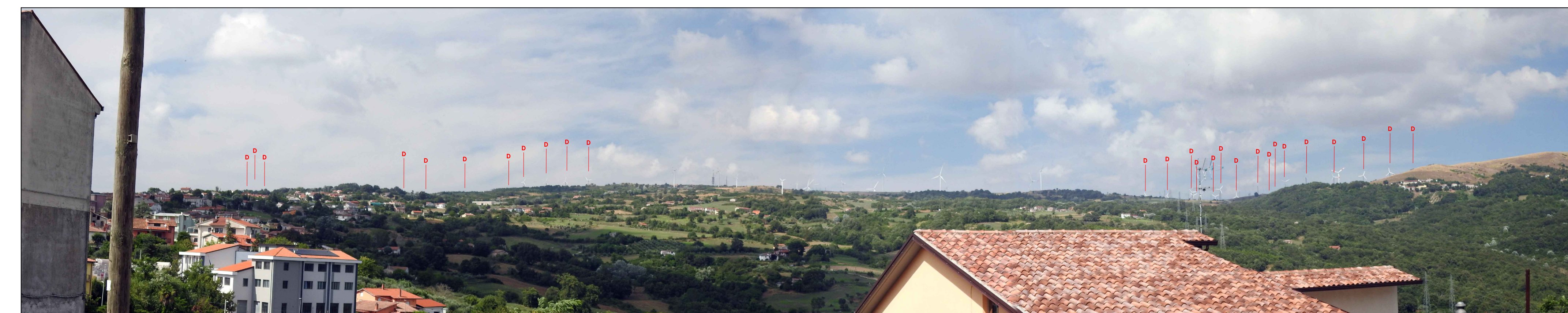
AEROGENERATORI IVPC DA DISMETTERE
