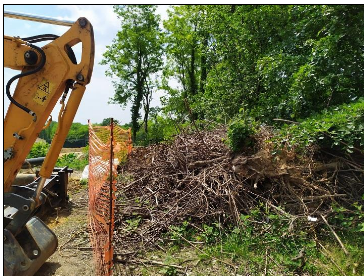
Figura Errore. Nel documento non esiste testo dello stile specificato.-3: Esempio di tronchi morti lasciati sul 2°Tratto da A.I. n.915 di S. Polo a Pieve di Soligo DN 300 (12").
