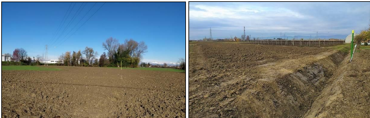
Figura Errore . Nel documento non esiste testo dello stile specificato.-3: Riprofilatura dei suoli sul 1°Tratto da A.I. n.915 di S. Polo a Salgareda DN 300 (12").
