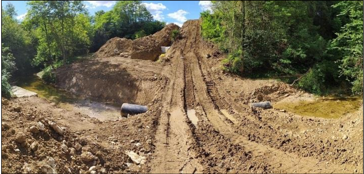
Figura Errata. Nel documento non esiste testo dello stile specificato.-2: Bypass idrico presso le stazioni di monitoraggio ASP04PS/VEP08RE.
