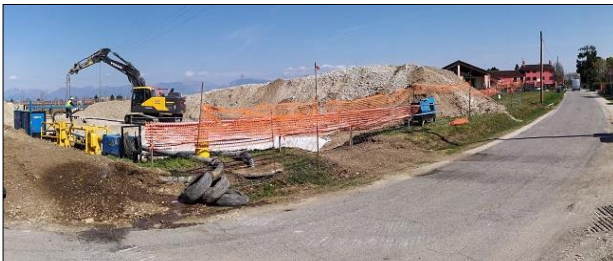
Figura 3.5.4/C – Barriera acustica topsoil.
