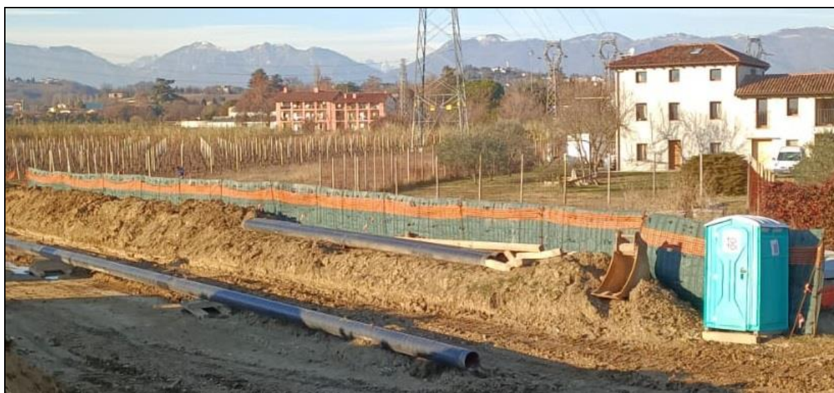
Figura 3.5.4/B – Barriera acustica topsoil e rete fonoassorbente.
