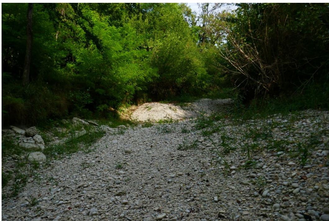
Torrente Lierza a monte dell'attraversamento
