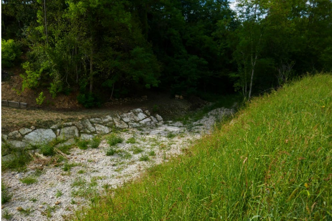
Torrente Lierza nel tratto oggetto di attraversamento
