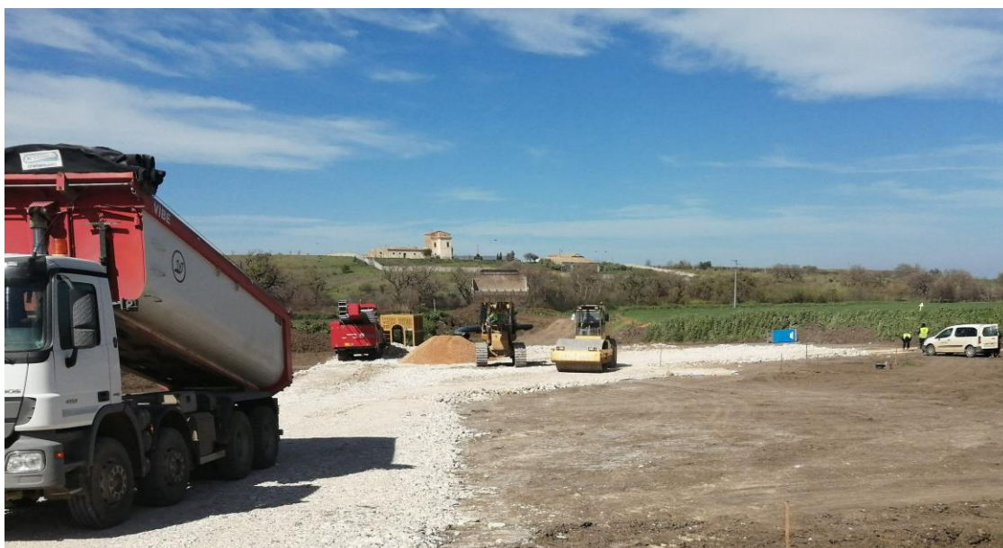
Fig. 2 – Preparazione area cantiere TOC “Monte Chiancone”
