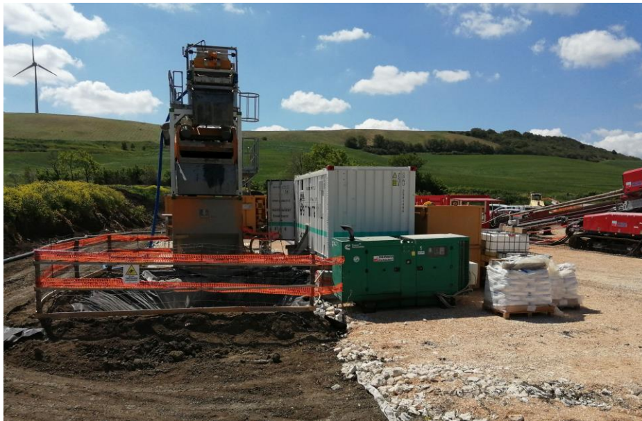
Fig. 3 – Vasche raccolta fanghi con telo impermeabile – area cantiere TOC “Monte Chiancone”
