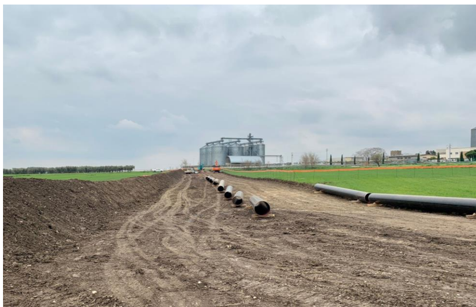
Fig. 1 – Tubazione sfilata in situ ed adagiata su stock in legno
