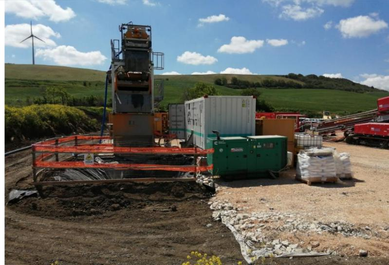
Area destinata alle attrezzature e alla movimentazione dei mezzi d'opera (materiale litoide su strato separatore in tessuto non tessuto) e vasca deposito smarino con telo impermeabile
