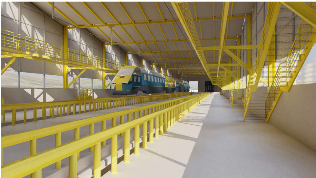
Due viste interne del grande spazio del ricovero mezzi; possono osservarsi gli elementi configuranti dello spazio: i binari sopraelevati, le passerelle laterali per l'accesso al piano dell'imperiale; le scale e le vie di esodo; la copertura a shed.
