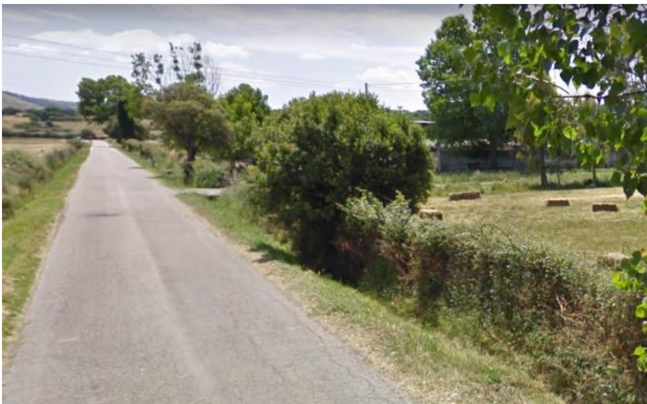
Foto 6: sopralluogo UR 2 - settembre 2021.
