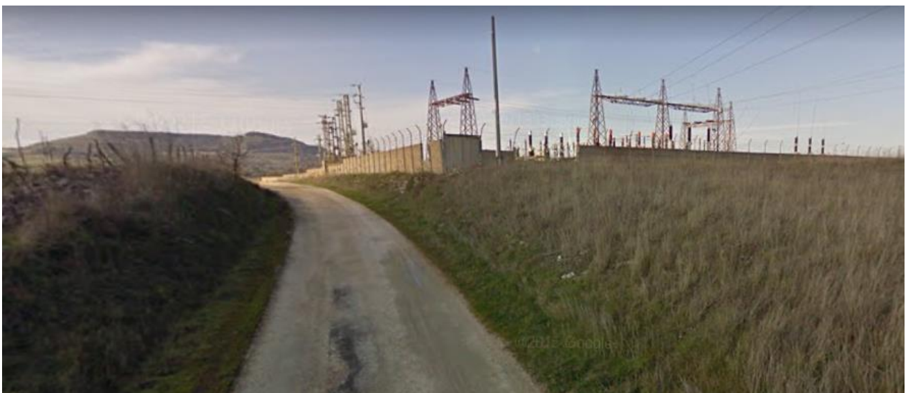
Foto 26: sopralluogo UR 10 - aprile 2022.
