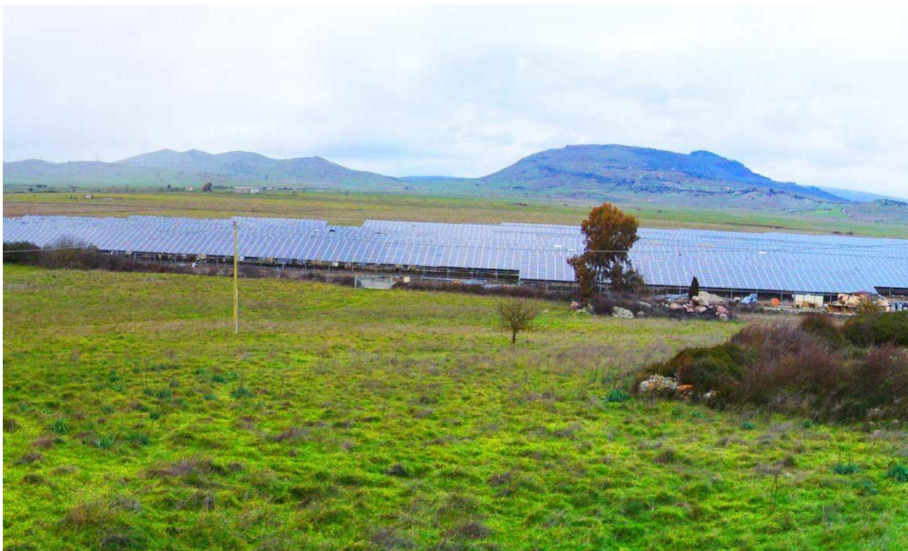
Foto 5: sopralluogo UR 2 - febbraio 2022.
