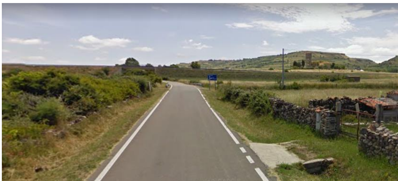
Foto 14: sopralluogo UR 6 - settembre 2021.
