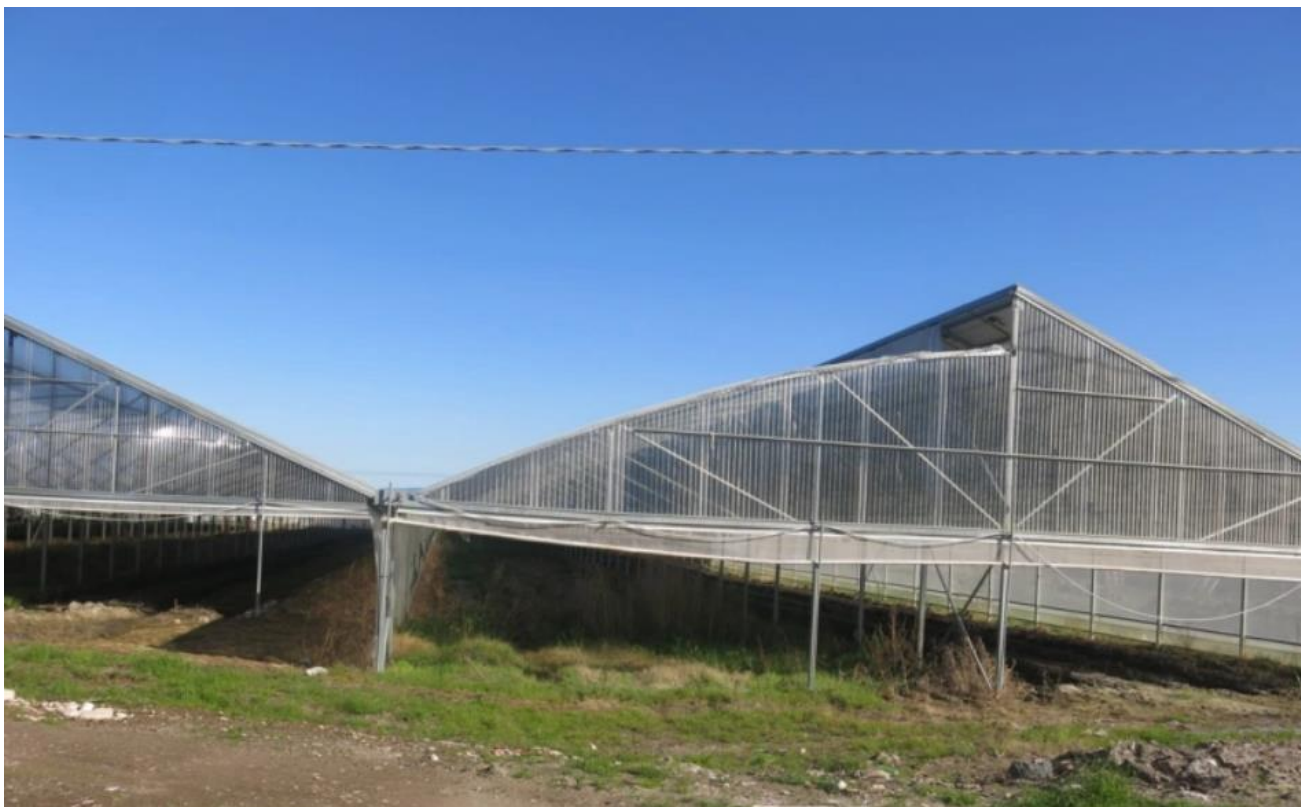
Foto 3: sopralluogo UR 1 - aprile 2022.
