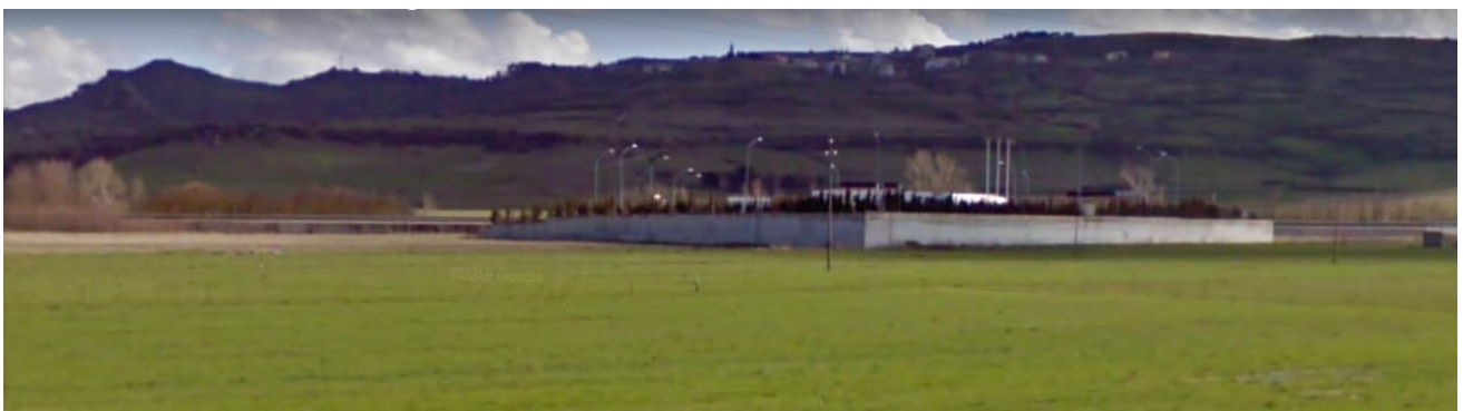
Foto 20: sopralluogo UR 9 - aprile 2022.
