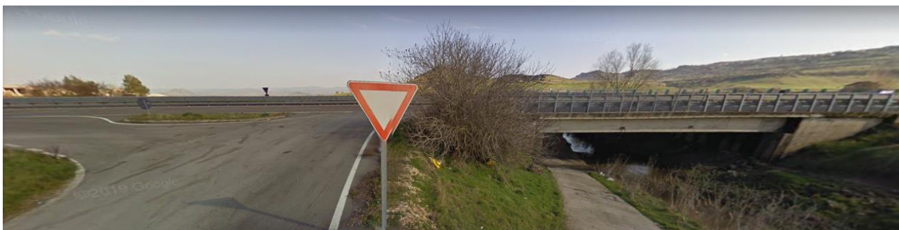
Foto 22: sopralluogo UR 10 - aprile 2022.
