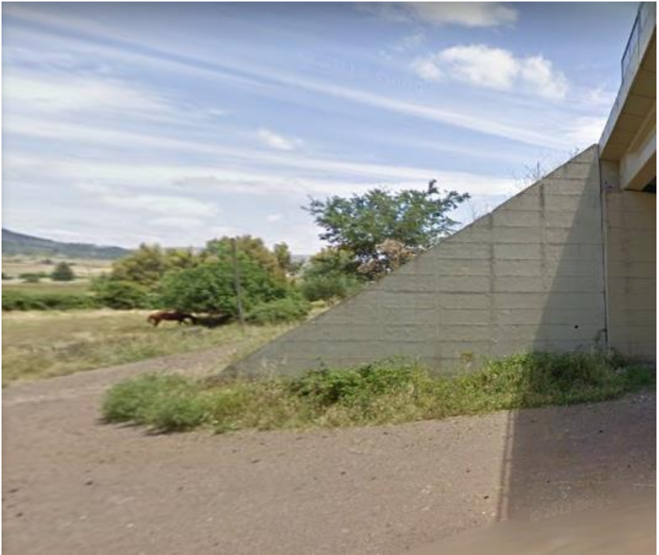
Foto 16: sopralluogo UR 7 - aprile 2022.
