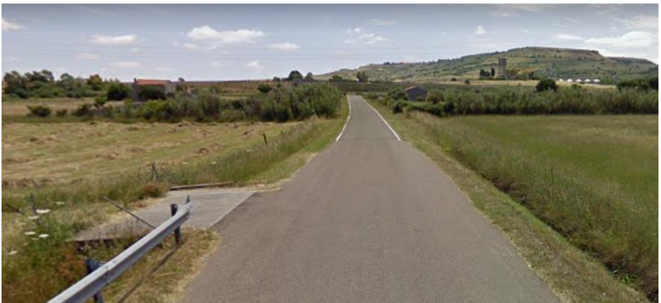
Foto 12: sopralluogo UR 5 - settembre 2021.
