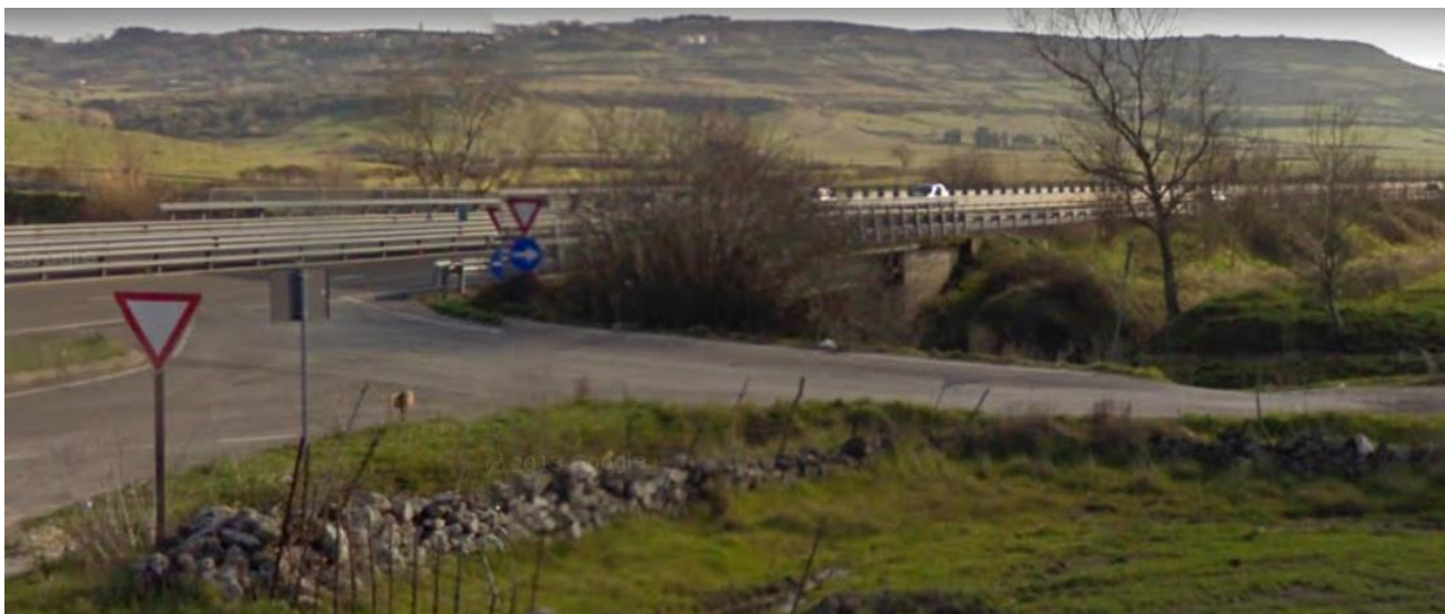
Foto 21: sopralluogo UR 10 - aprile 2022.
