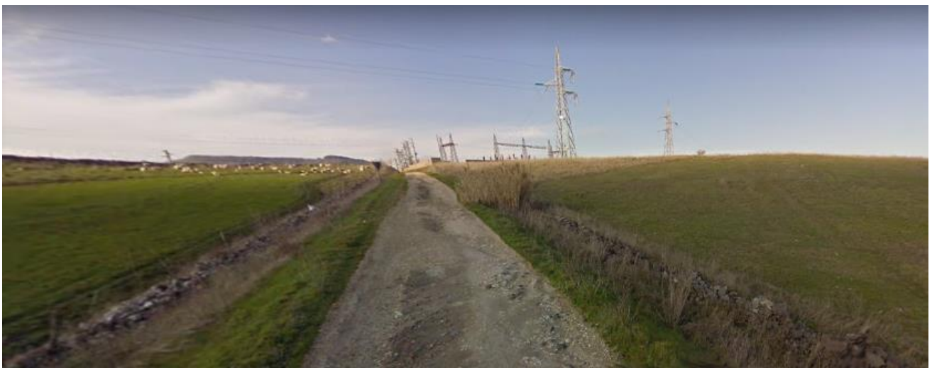
Foto 25: sopralluogo UR 10 - aprile 2022.
