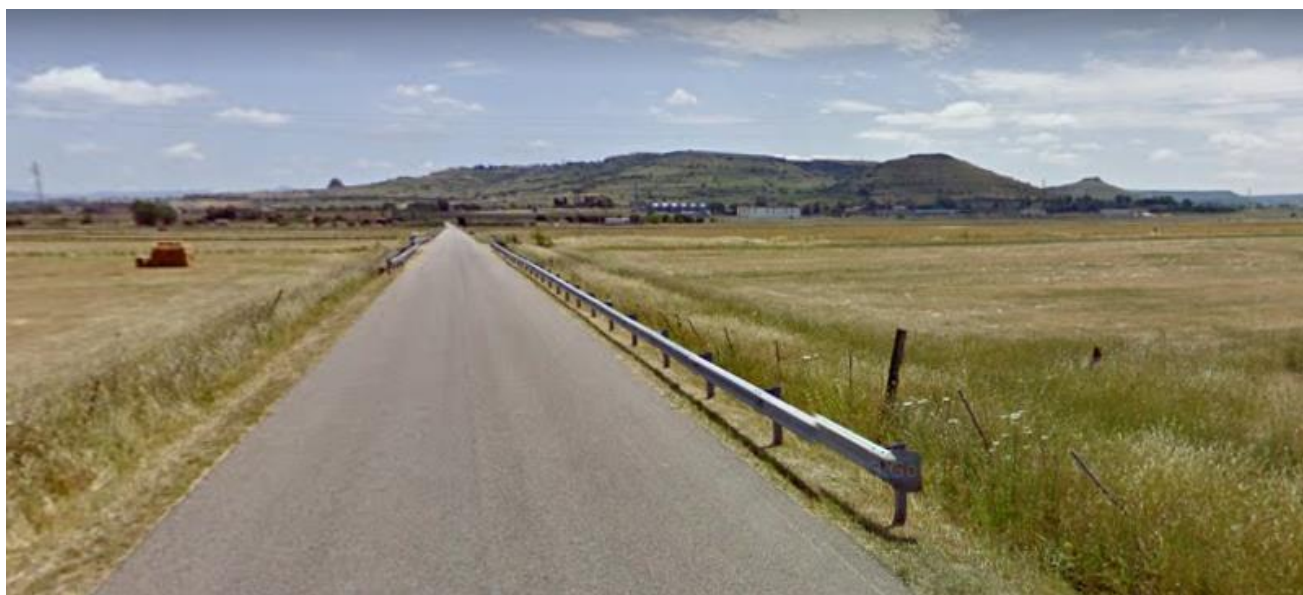
Foto 10: sopralluogo UR 4 - settembre 2021.
