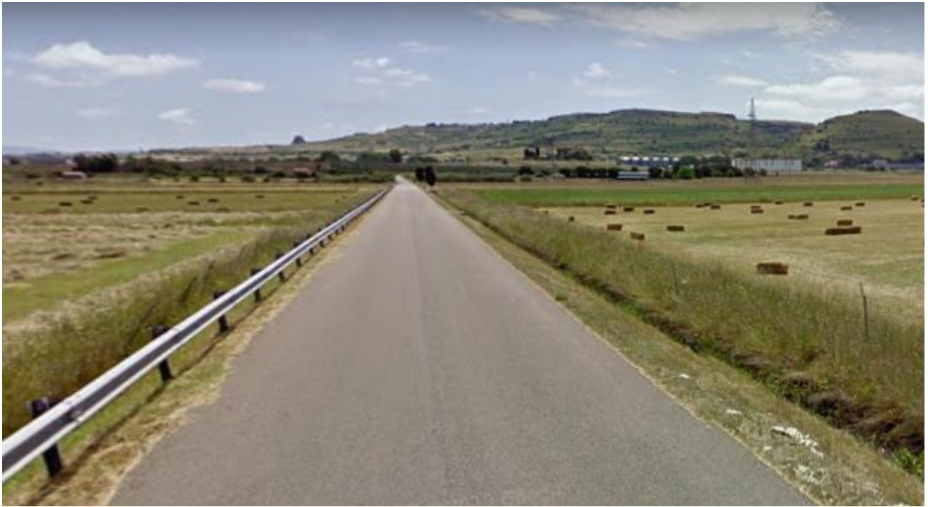
Foto 11: sopralluogo UR 5 - settembre 2021.
