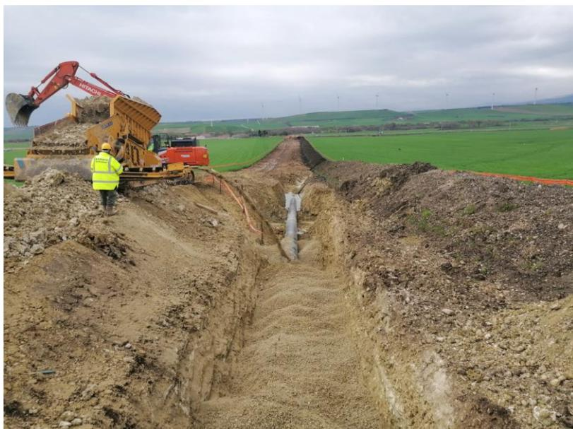
Fig. 1 Operazioni di prerinterro della condotta ed ispezione del materiale con vibrovaglio
