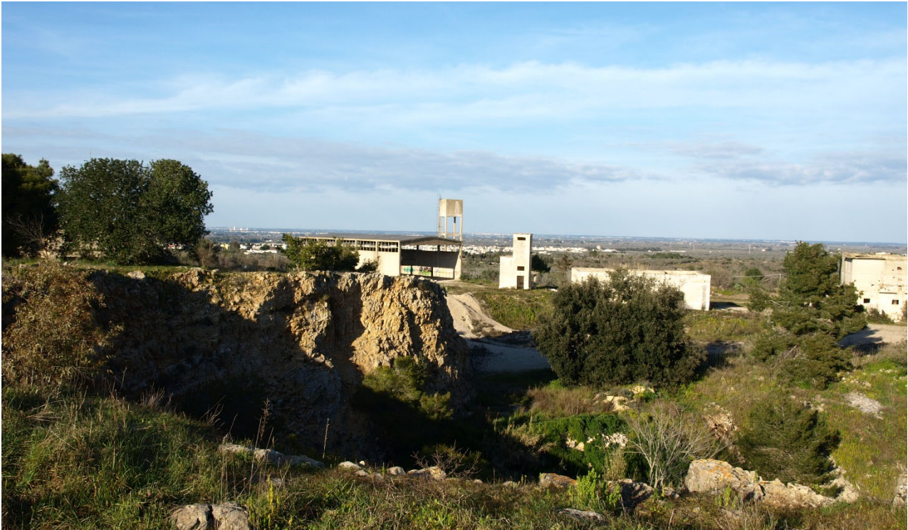
Figura 55 – Cava dismessa nella zona di Sant'Eleuterio
