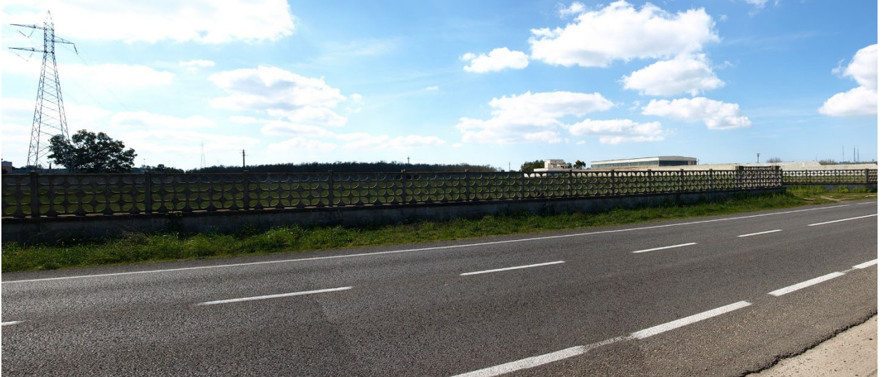
Figura 75 – punto n° 16 – Visuale da SP361 ingresso Masseria Quagliasiero (impianto non visibile)
