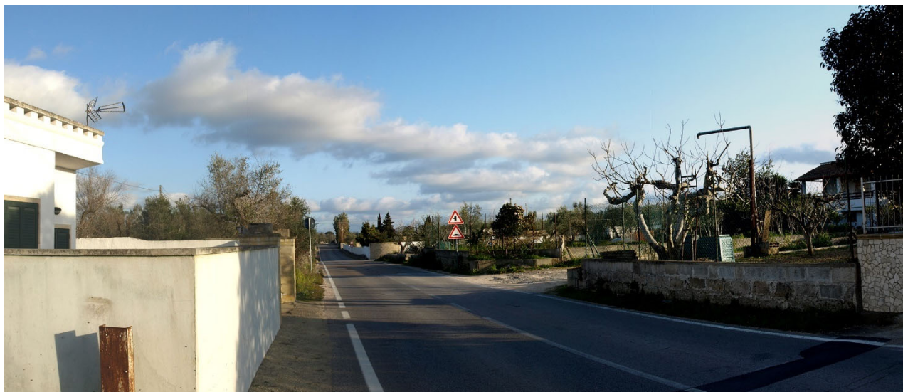
Figura 72 – punto n° 13 – Visuale da SP42 (impianto non visibile)
