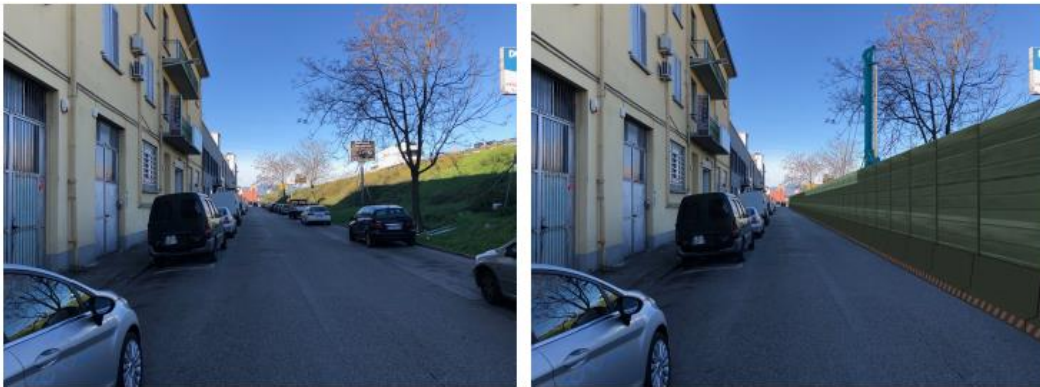
Figura 27- Confronto ante operam/corso d'opera del cantiere per la realizzazione delle palificate via T. Tasso
