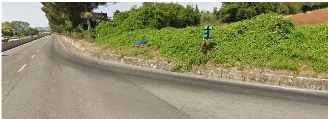
Figura 54 – Muro esistente in corrispondenza dell’intervento 6
