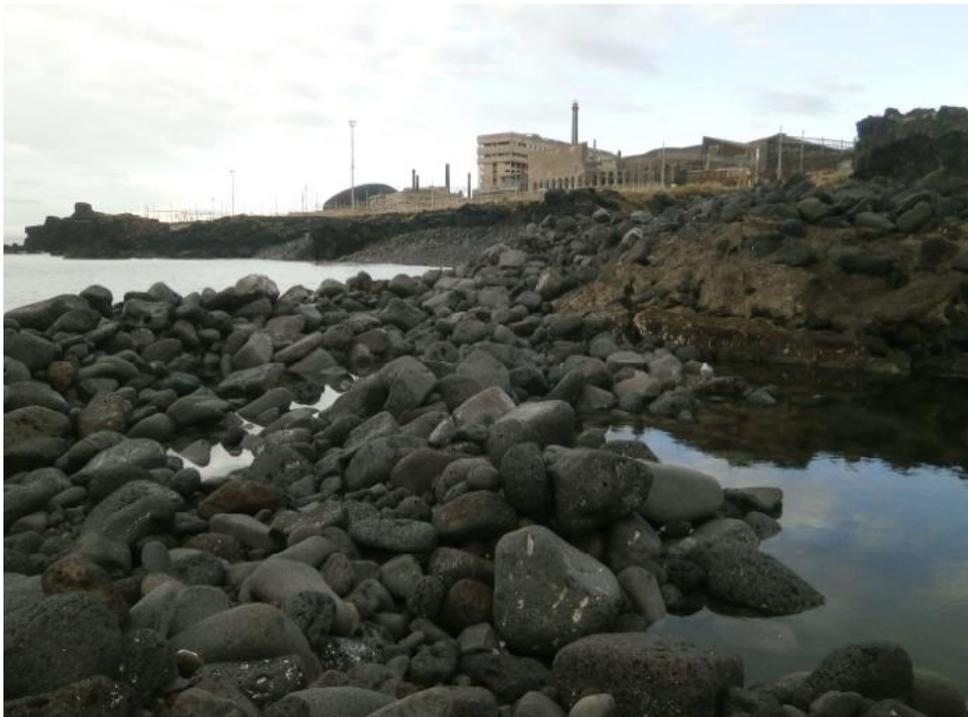
Figura 21. Indebolimento alla base del braccio esistente per azione del mare e chiusura dell'imboccatura del porto
