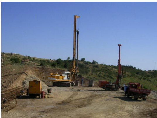
Realizzazione pali trivellati
