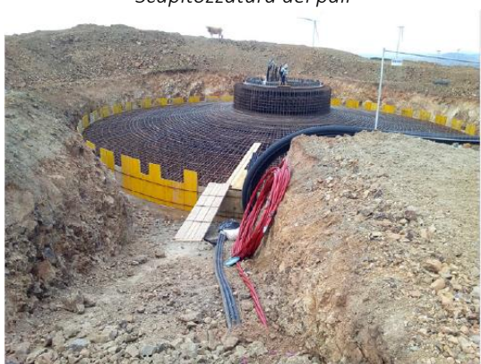
Posa ferri e casseratura
