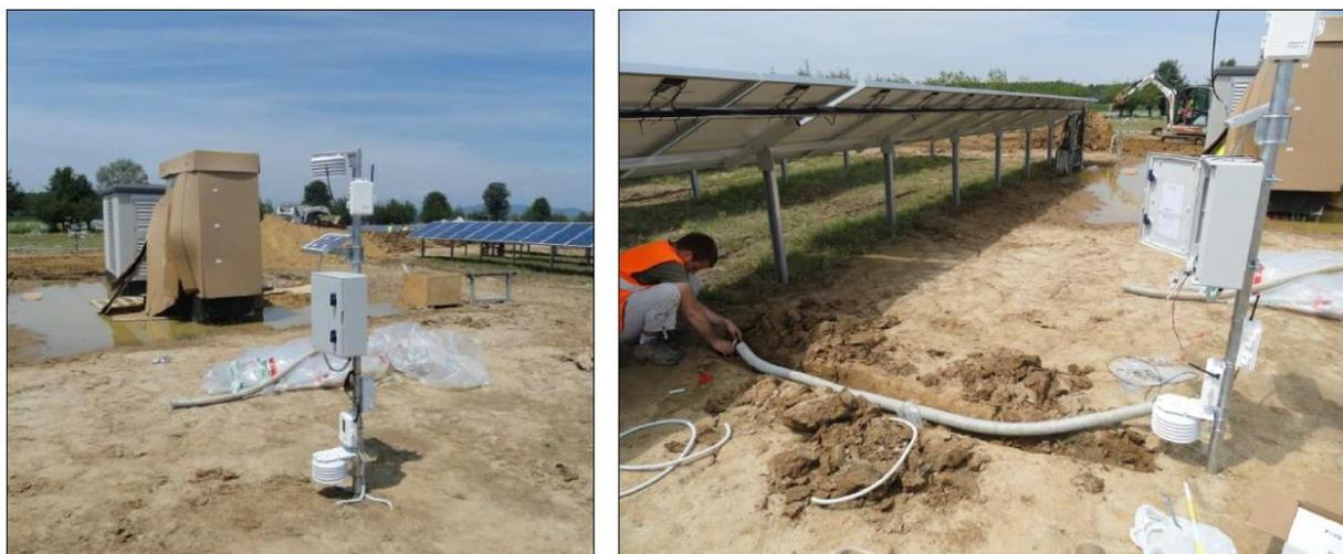
**Figura 6.** Esempio di stazione di monitoraggio meteo-ambientale e sua installazione (durante la fase di costruzione di un impianto FV) – realizzata ad opera degli scriventi.
